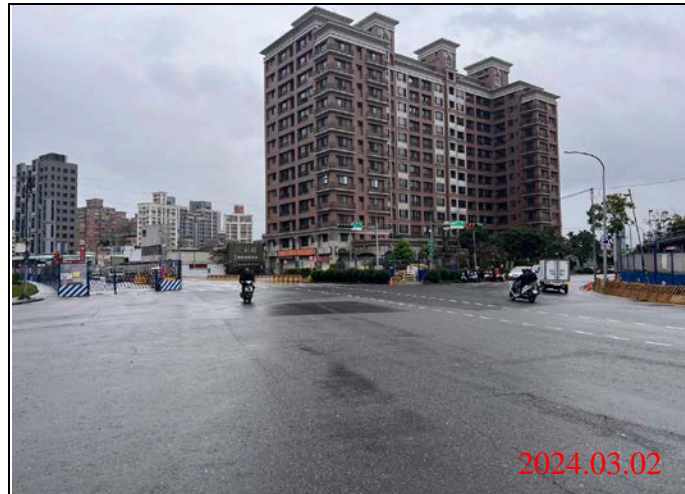
巡查日期地點：113.03.02/ Y22車站 照片說明：路面狀況
