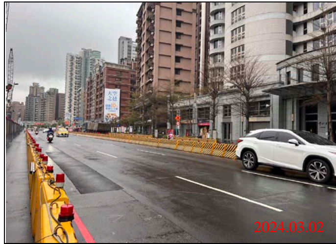
巡查日期地點：113.03.02/ Y23車站 照片說明：路面狀況
