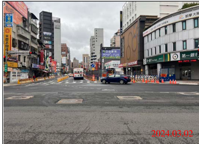
巡查日期地點：113.03.02/ Y21車站 照片說明：路面狀況
