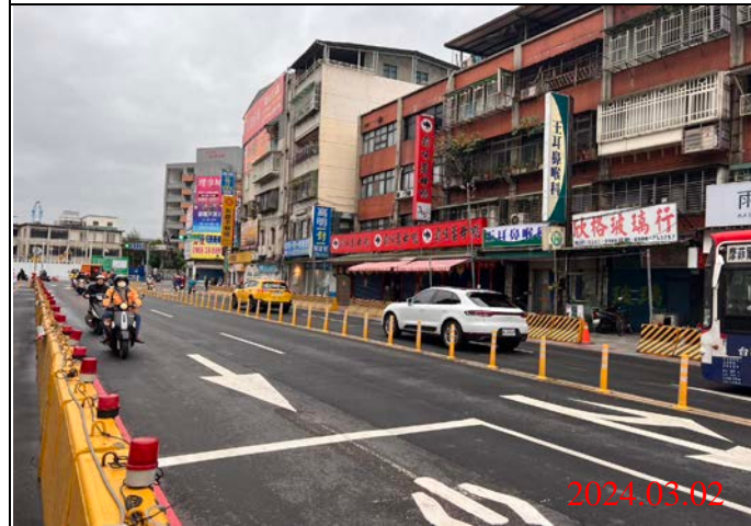
巡查日期地點：113.03.02/ Y21車站 照片說明：路面狀況
