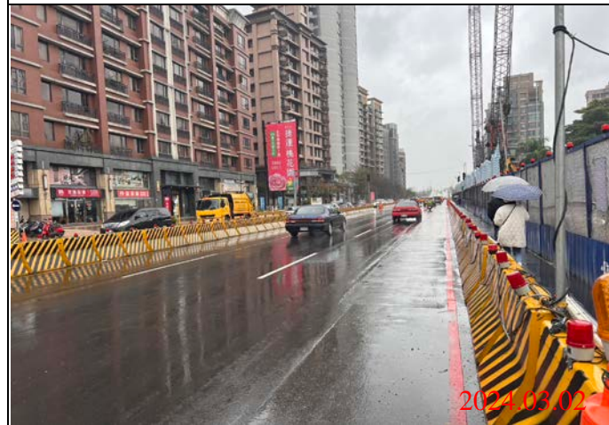
巡查日期地點：113.03.02/ Y23車站 照片說明：路面狀況
