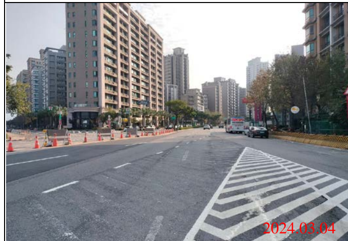
巡查日期地點：113.03.04/ Y22車站 照片說明：路面狀況
