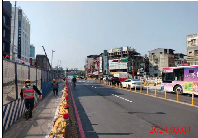
巡查日期地點：113.03.04/ Y21車站 照片說明：路面狀況
