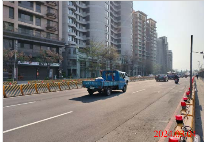
巡查日期地點：113.03.04/ Y23車站 照片說明：路面狀況
