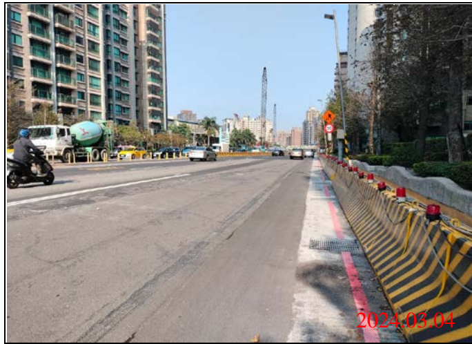
巡查日期地點：113.03.04/ Y23車站 照片說明：路面狀況
