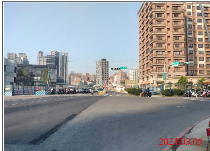
巡查日期地點：113.03.05/ Y22車站 照片說明：路面狀況
