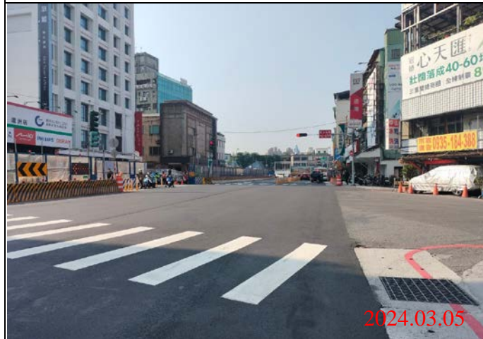
巡查日期地點：113.03.05/ Y21車站 照片說明：路面狀況
