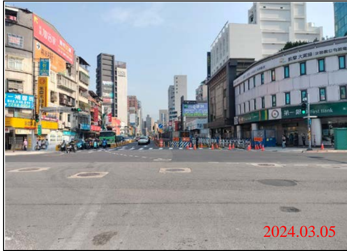
巡查日期地點：113.03.05/ Y21車站 照片說明：路面狀況
