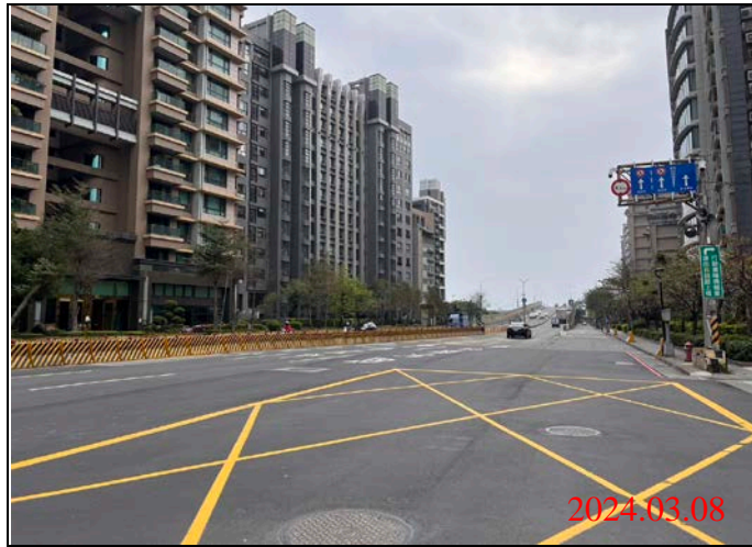
巡查日期地點：113.03.08/ Y23車站 照片說明：路面狀況
