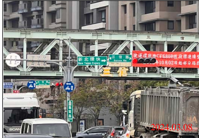
巡查日期地點：113.03.08/ Y23車站 照片說明：牌面設置狀況
