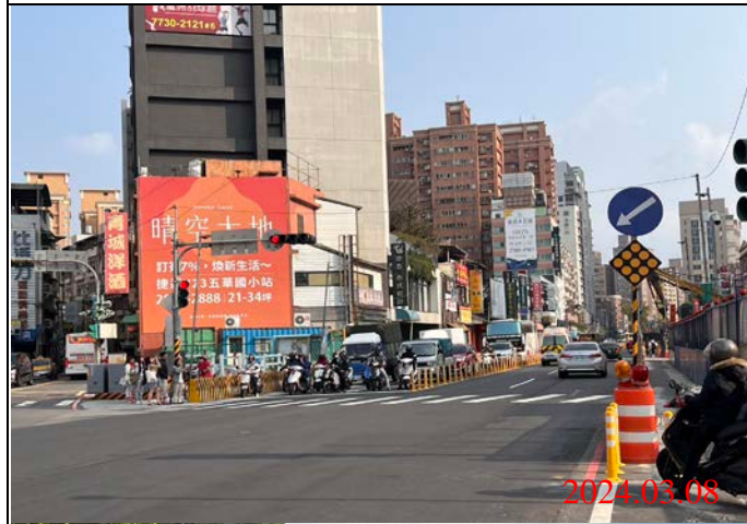
巡查日期地點：113.03.08/ Y21車站 照片說明：路面狀況
