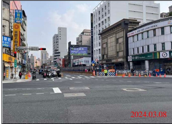
巡查日期地點：113.03.08/ Y21車站 照片說明：路面狀況
