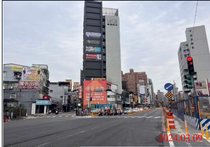
巡查日期地點：113.03.09/ Y21車站 照片說明：路面狀況
