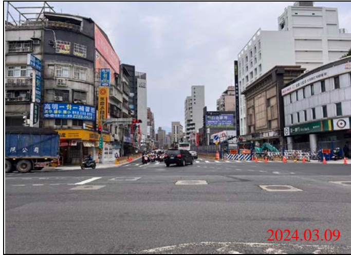
巡查日期地點：113.03.09/ Y21車站 照片說明：路面狀況
