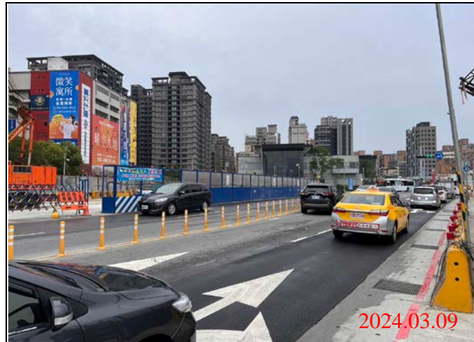
巡查日期地點：113.03.09/ Y22車站 照片說明：路面狀況
