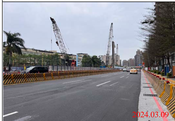
巡查日期地點：113.03.09/ Y23車站 照片說明：路面狀況
