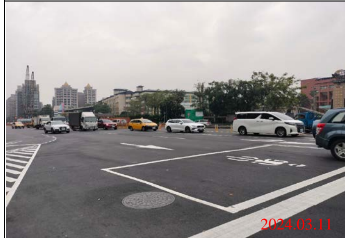
巡查日期地點：113.03.11/ Y23車站 照片說明：路面狀況
