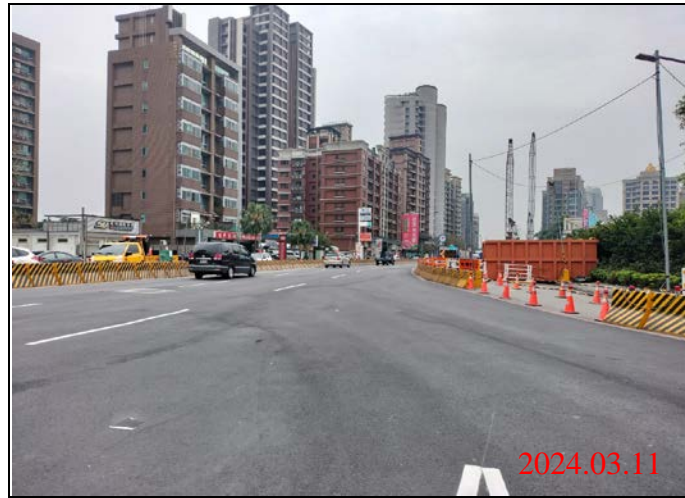
巡查日期地點：113.03.11/ Y23車站 照片說明：路面狀況
