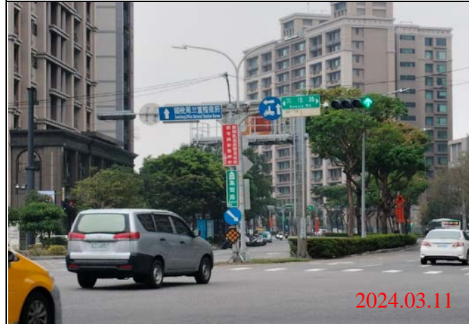
巡查日期地點：113.03.11/ Y23車站 照片說明：牌面設置狀況
