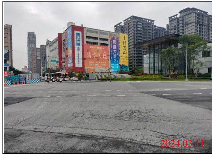
巡查日期地點：113.03.11/ Y22車站 照片說明：路面狀況
