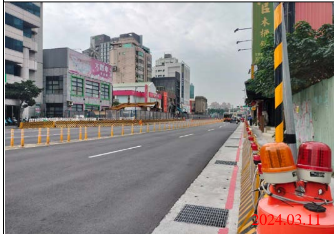
巡查日期地點：113.03.11/ Y21車站 照片說明：路面狀況
