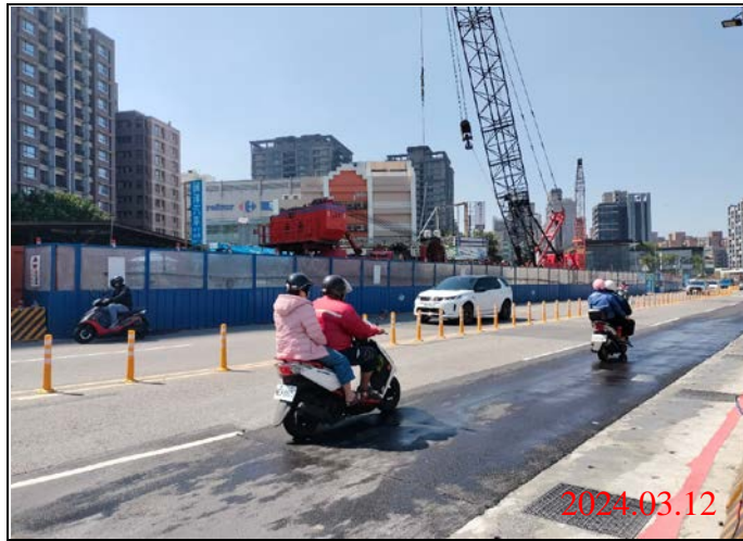
巡查日期地點：113.03.12/ Y22車站 照片說明：路面狀況
