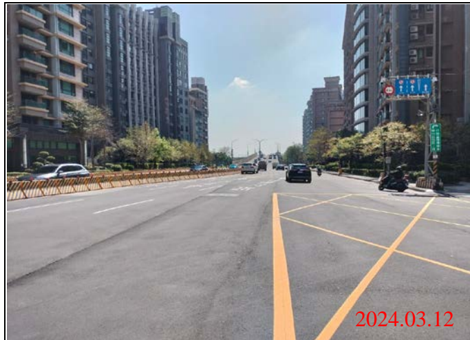
巡查日期地點：113.03.12/ Y23車站 照片說明：路面狀況
