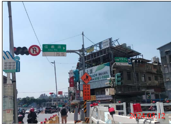
巡查日期地點：113.03.12/ Y21車站 照片說明：牌面設置狀況
