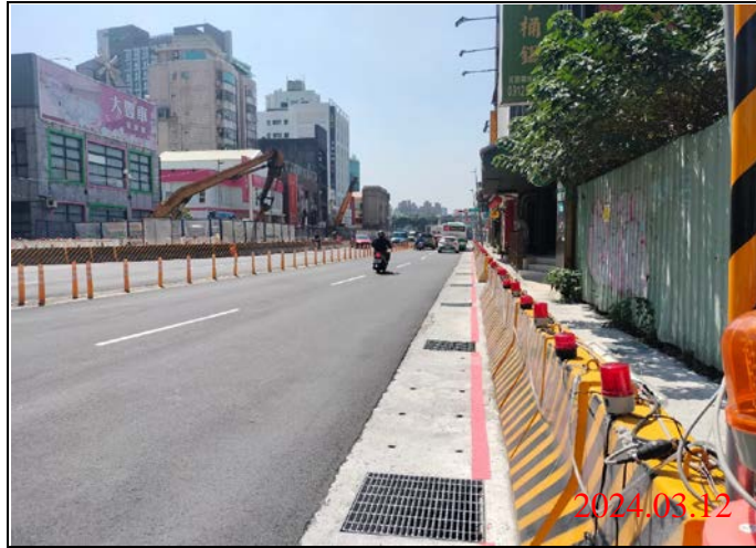
巡查日期地點：113.03.12/ Y21車站 照片說明：路面狀況
