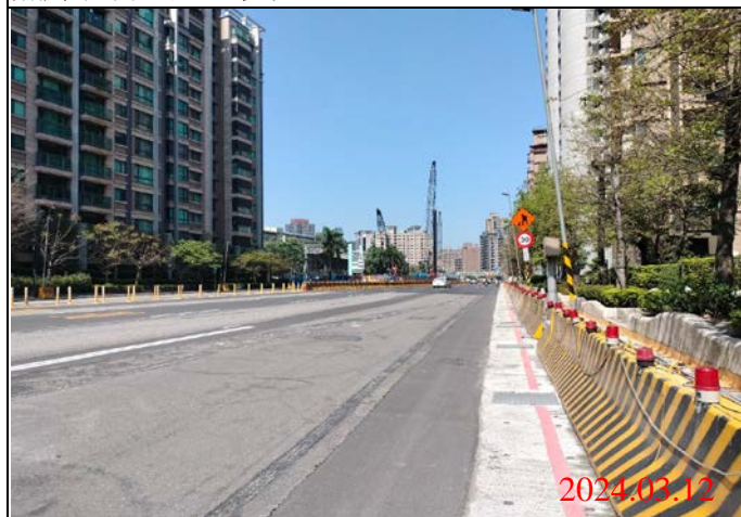
巡查日期地點：113.03.12/ Y23車站 照片說明：路面狀況
