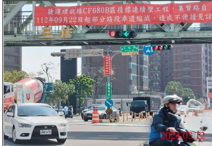
巡查日期地點：113.03.12/ Y23車站 照片說明：牌面設置狀況
