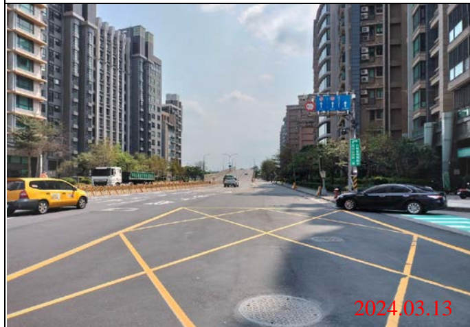
巡查日期地點：113.03.13/ Y23車站 照片說明：路面狀況
