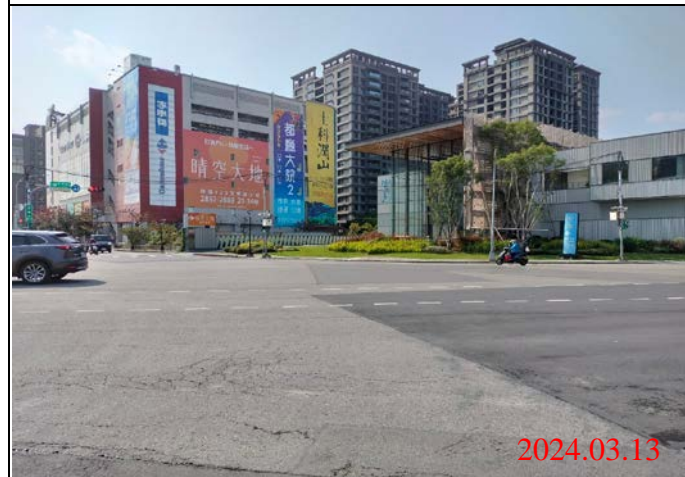
巡查日期地點：113.03.13/ Y22車站 照片說明：路面狀況
