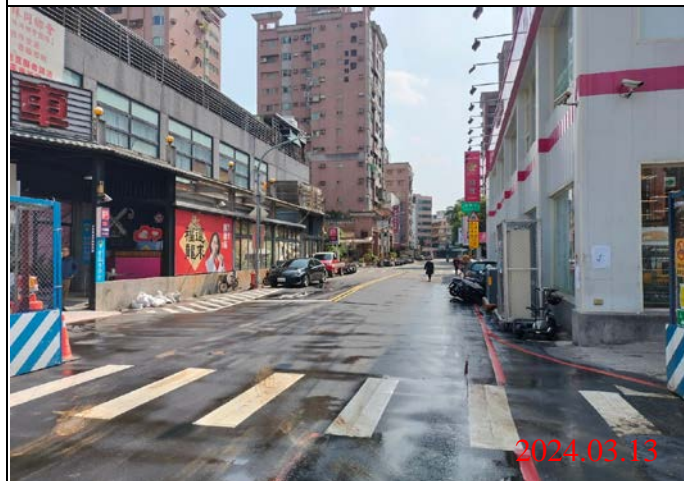
巡查日期地點：113.03.13/ Y21車站 照片說明：路面狀況
