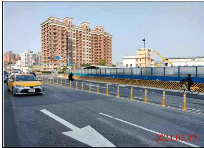
巡查日期地點：113.03.13/ Y22車站 照片說明：路面狀況
