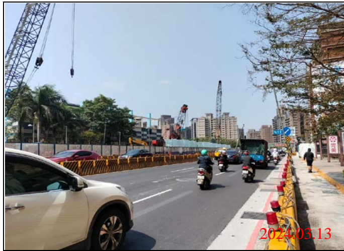
巡查日期地點：113.03.13/ Y23車站 照片說明：路面狀況
