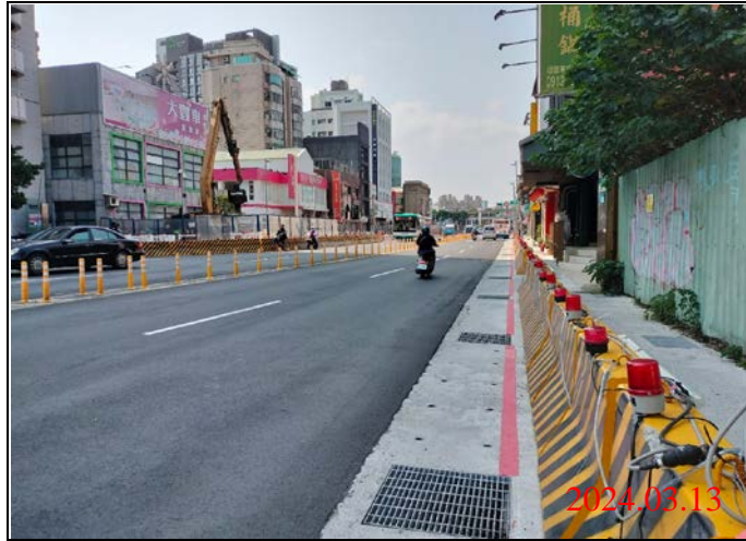
巡查日期地點：113.03.13/ Y21車站 照片說明：路面狀況
