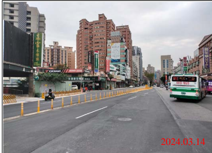
巡查日期地點：113.03.14/ Y21車站 照片說明：路面狀況
