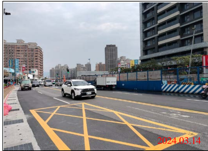
巡查日期地點：113.03.14/ Y22車站 照片說明：路面狀況
