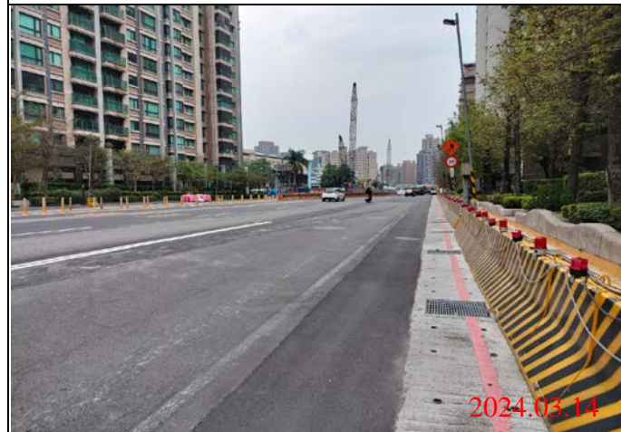
巡查日期地點：113.03.14/ Y23車站 照片說明：路面狀況
