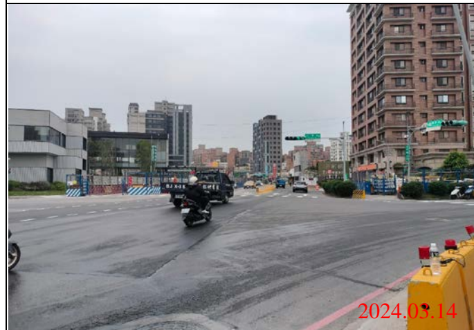
巡查日期地點：113.03.14/ Y22車站 照片說明：路面狀況
