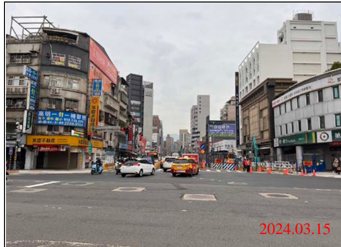
巡查日期地點：113.03.15/ Y21車站 照片說明：路面狀況
