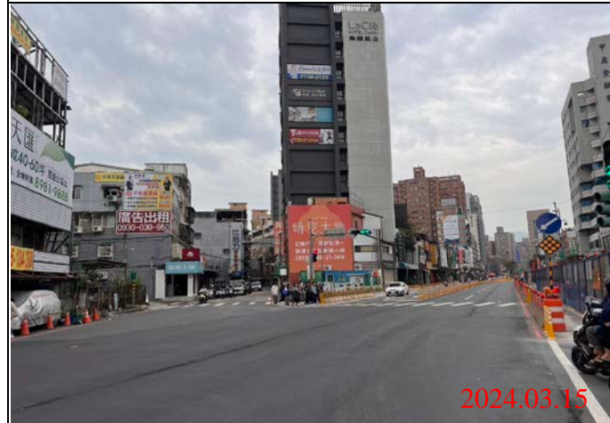
巡查日期地點：113.03.15/ Y21車站 照片說明：路面狀況
