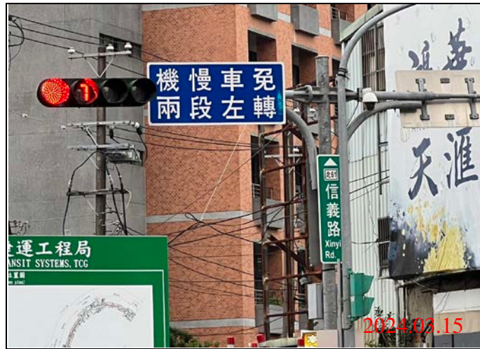
巡查日期地點：113.03.15/ Y21車站 照片說明：牌面設置狀況
