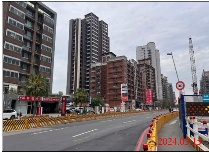
巡查日期地點：113.03.15/ Y23車站 照片說明：路面狀況
