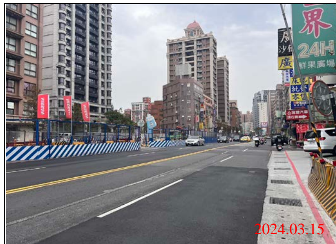
巡查日期地點：113.03.15/ Y22車站 照片說明：路面狀況
