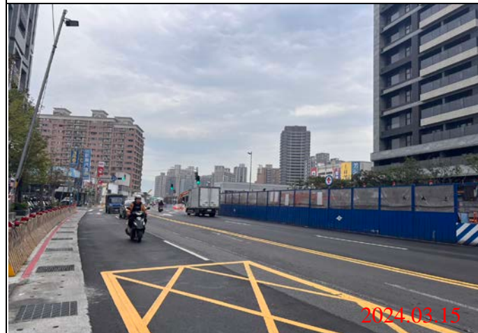
巡查日期地點：113.03.15/ Y22車站 照片說明：路面狀況
