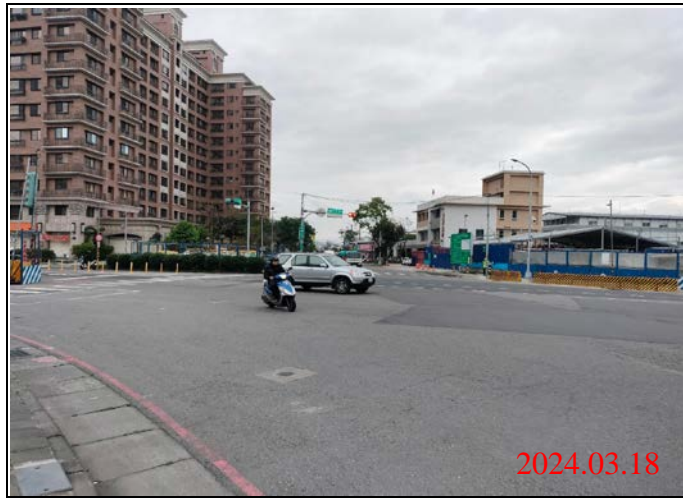
巡查日期地點：113.03.18/ Y22車站 照片說明：路面狀況
