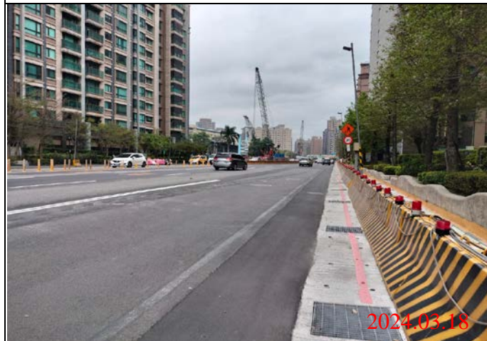
巡查日期地點：113.03.18/ Y23車站 照片說明：路面狀況
