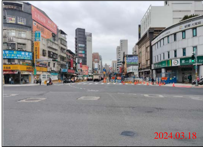
巡查日期地點：113.03.18/ Y21車站 照片說明：路面狀況
