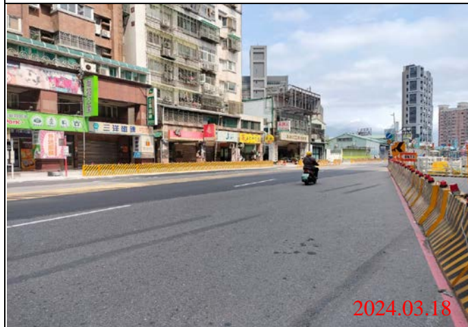
巡查日期地點：113.03.18/ Y22車站 照片說明：路面狀況
