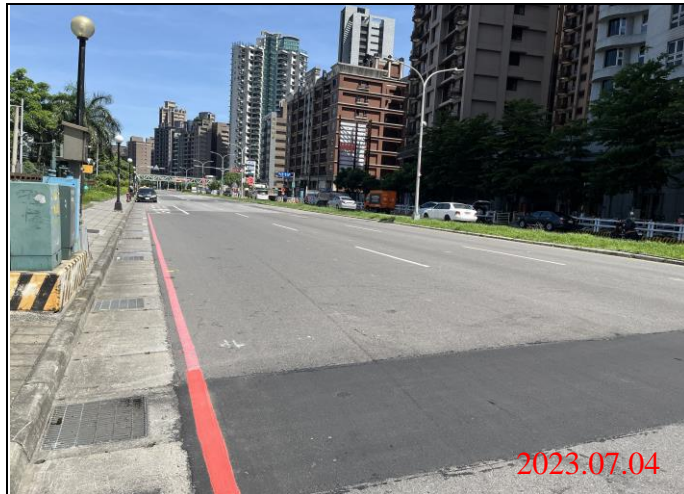
巡查日期地點：112.07.04/ Y23車站 照片說明：路面狀況
