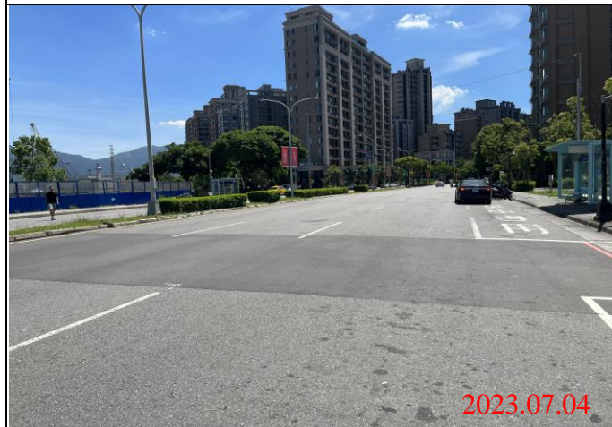
巡查日期地點：112.07.04/ Y22車站 照片說明：路面狀況
