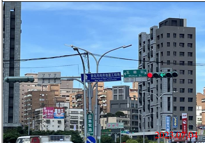
巡查日期地點：112.07.04/ Y22車站 照片說明：牌面設置狀況
