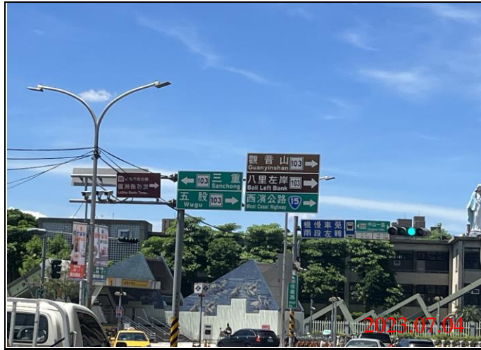
巡查日期地點：112.07.04/ Y21車站 照片說明：牌面設置狀況
