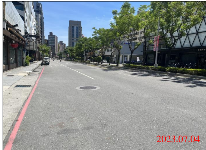
巡查日期地點：112.07.04/ Y21車站 照片說明：路面狀況
