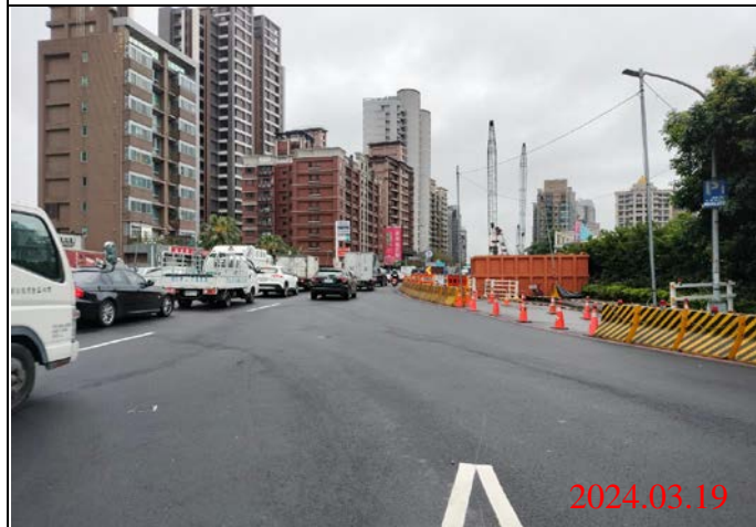
巡查日期地點：113.03.19/ Y23車站 照片說明：路面狀況
