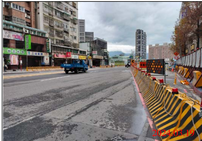
巡查日期地點：113.03.19/ Y22車站 照片說明：路面狀況
