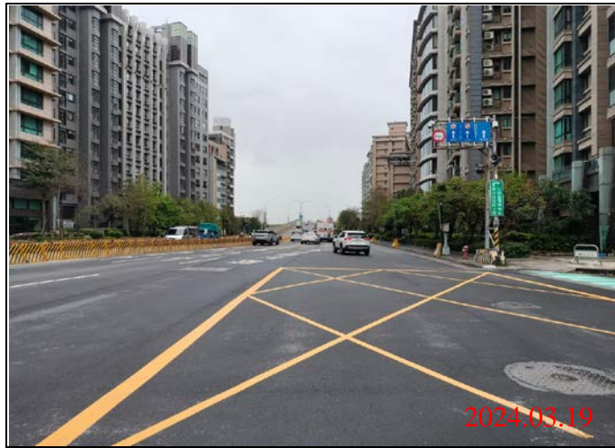
巡查日期地點：113.03.19/ Y23車站 照片說明：路面狀況
