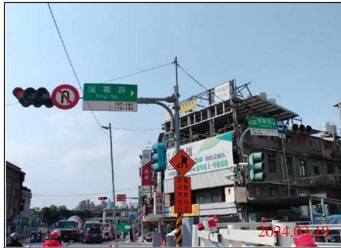
巡查日期地點：113.03.19/ Y21車站 照片說明：牌面設置狀況
