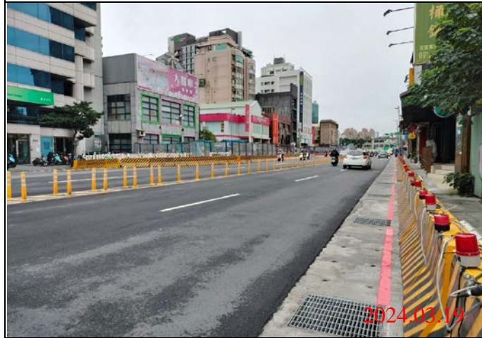
巡查日期地點：113.03.19/ Y21車站 照片說明：路面狀況
