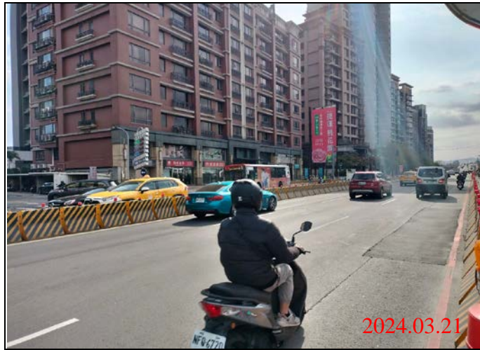
巡查日期地點：113.03.21/ Y23車站 照片說明：路面狀況
