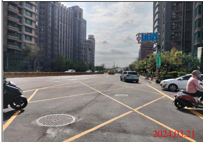
巡查日期地點：113.03.21/ Y23車站 照片說明：路面狀況
