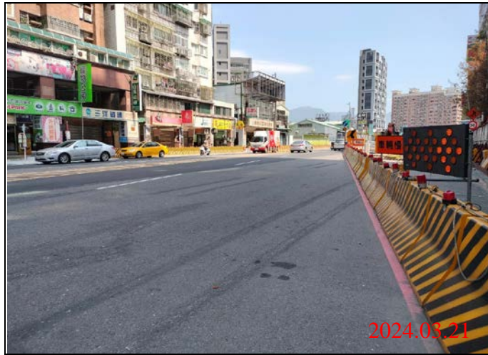
巡查日期地點：113.03.21/ Y22車站 照片說明：路面狀況
