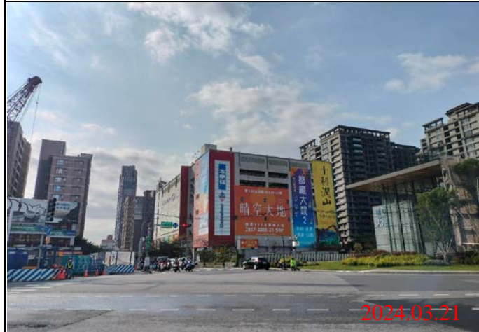
巡查日期地點：113.03.21/ Y22車站 照片說明：路面狀況
