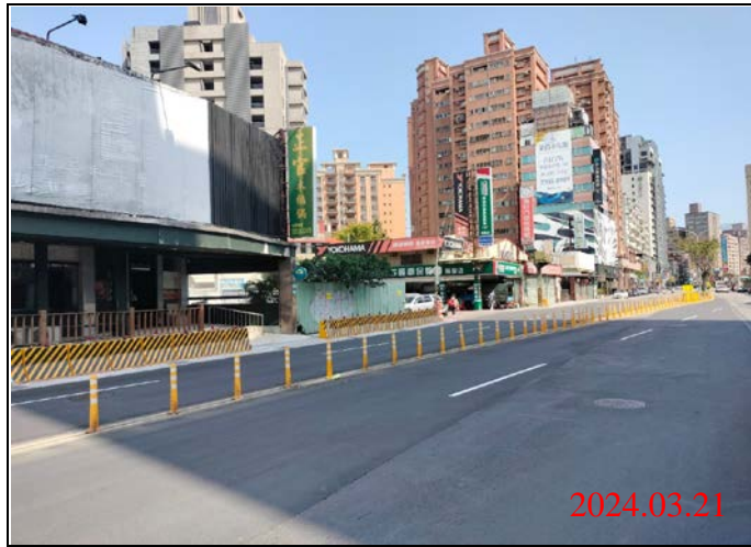
巡查日期地點：113.03.21/ Y21車站 照片說明：路面狀況
