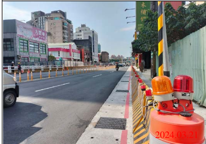
巡查日期地點：113.03.21/ Y21車站 照片說明：路面狀況
