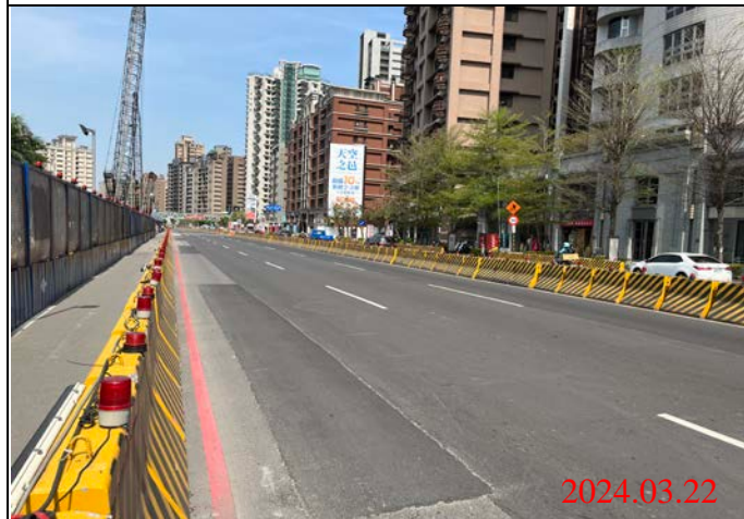
巡查日期地點：113.03.22/ Y23車站 照片說明：路面狀況
