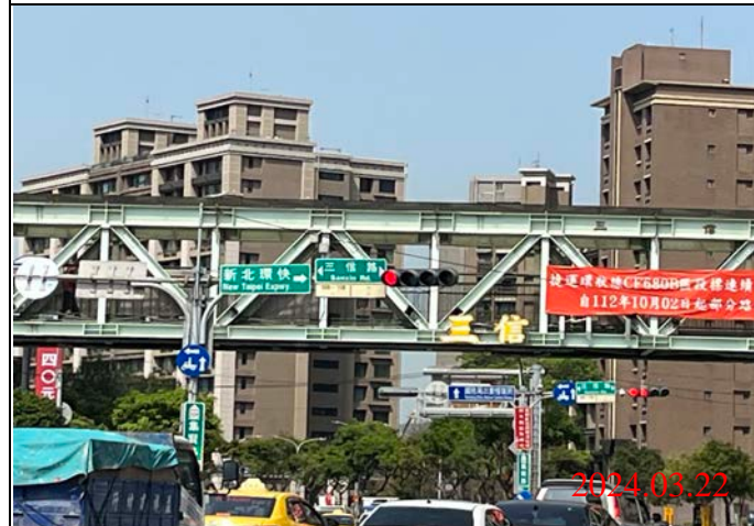
巡查日期地點：113.03.22/ Y23車站 照片說明：牌面設置狀況
