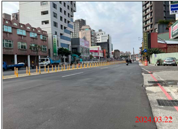
巡查日期地點：113.03.22/ Y21車站 照片說明：路面狀況
