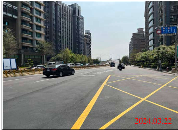
巡查日期地點：113.03.22/ Y23車站 照片說明：路面狀況
