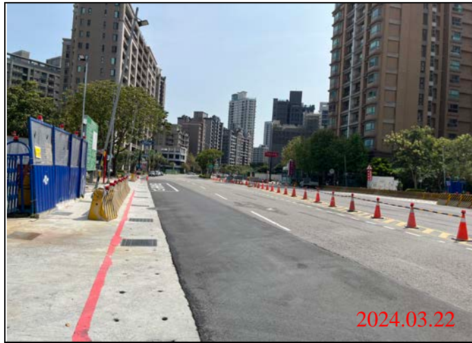
巡查日期地點：113.03.22/ Y22車站 照片說明：路面狀況
