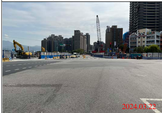
巡查日期地點：113.03.22/ Y22車站 照片說明：路面狀況
