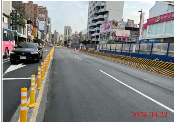
巡查日期地點：113.03.22/ Y21車站 照片說明：路面狀況
