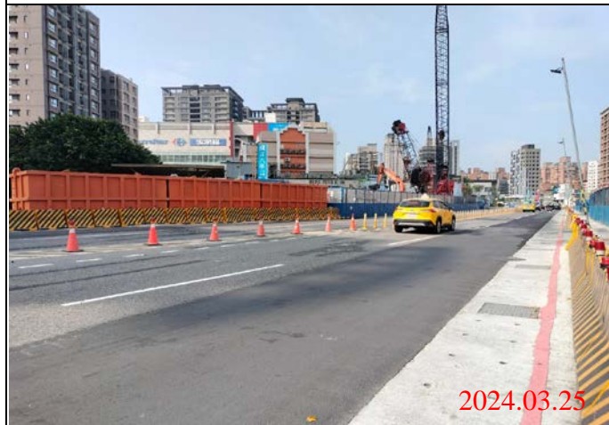
巡查日期地點：113.03.25/ Y22車站 照片說明：路面狀況
