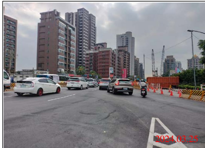
巡查日期地點：113.03.25/ Y23車站 照片說明：路面狀況
