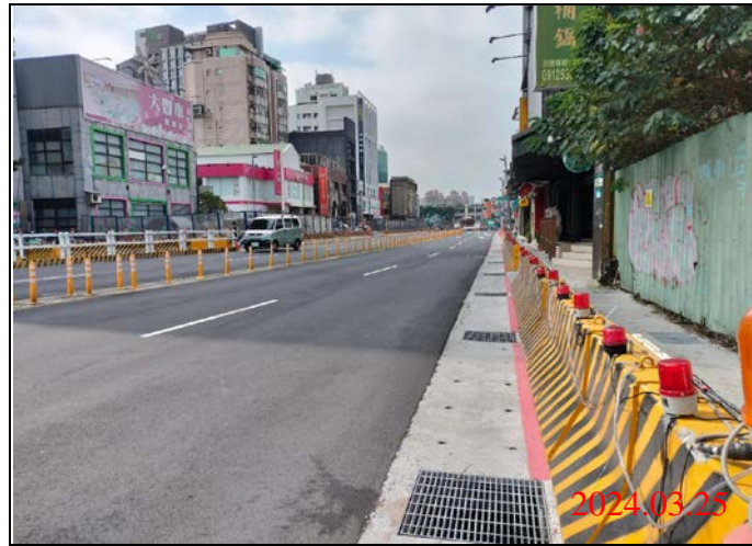
巡查日期地點：113.03.25/ Y21車站 照片說明：路面狀況
