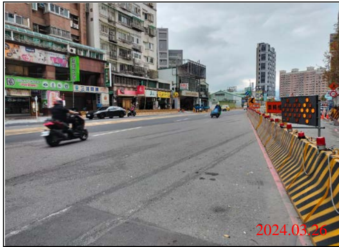
巡查日期地點：113.03.26/ Y22車站 照片說明：路面狀況
