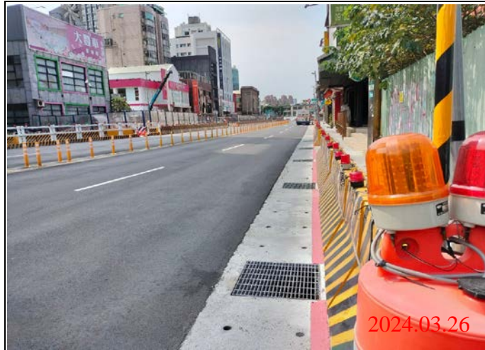
巡查日期地點：113.03.26/ Y21車站 照片說明：路面狀況
