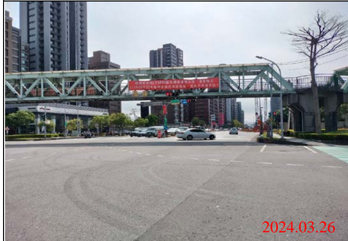
巡查日期地點：113.03.26/ Y23車站 照片說明：路面狀況
