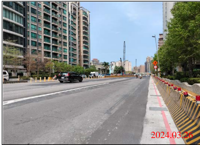
巡查日期地點：113.03.26/ Y23車站 照片說明：路面狀況
