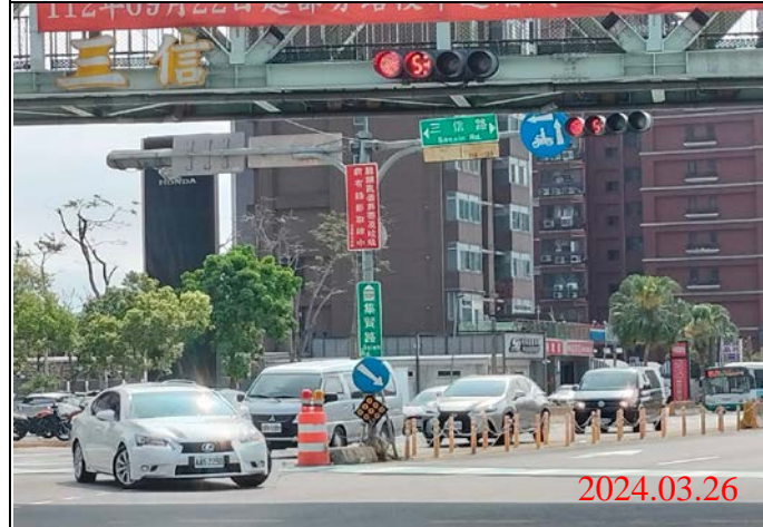
巡查日期地點：113.03.26/ Y23車站 照片說明：牌面設置狀況
