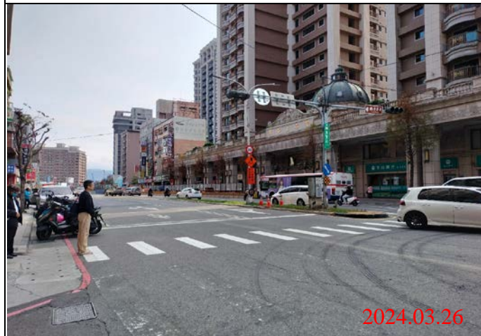
巡查日期地點：113.03.26/ Y22車站 照片說明：路面狀況
