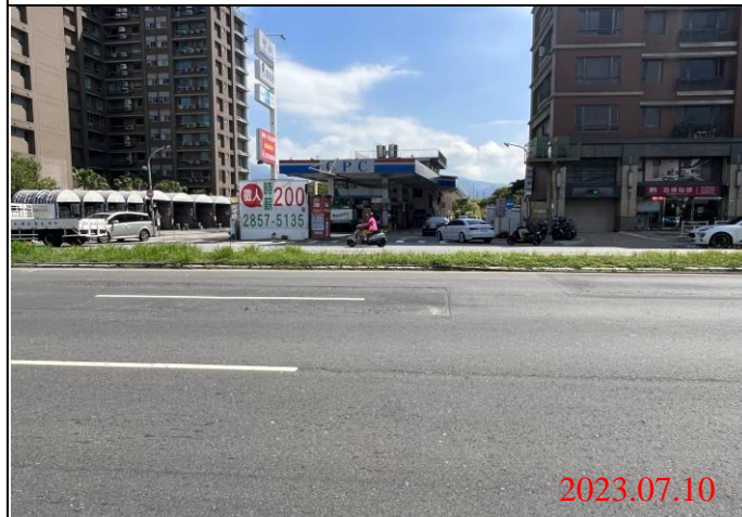
巡查日期地點：112.07.10/ Y23車站 照片說明：路面龜裂狀況
