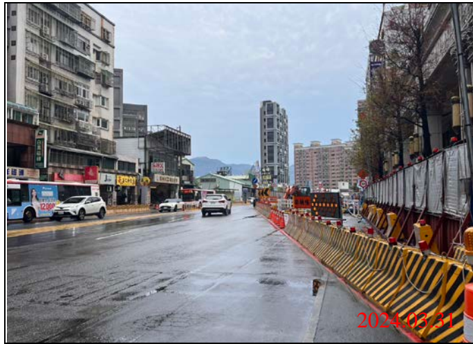
巡查日期地點：113.03.31/ Y22車站 照片說明：路面狀況
