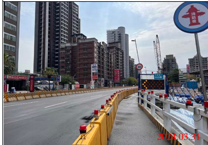
巡查日期地點：113.03.31/ Y23車站 照片說明：路面狀況
