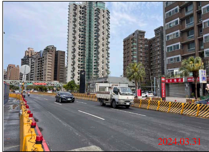
巡查日期地點：113.03.31/ Y23車站 照片說明：路面狀況
