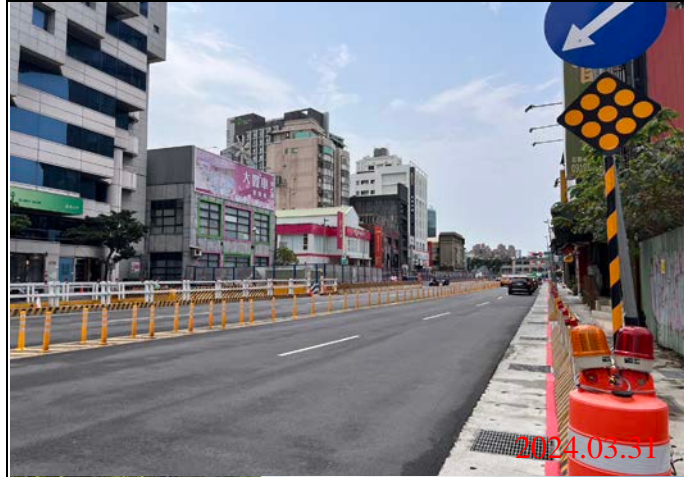
巡查日期地點：113.03.31/ Y21車站 照片說明：路面狀況
