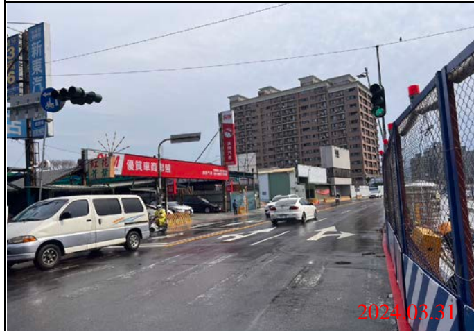
巡查日期地點：113.03.31/ Y22車站 照片說明：路面狀況
