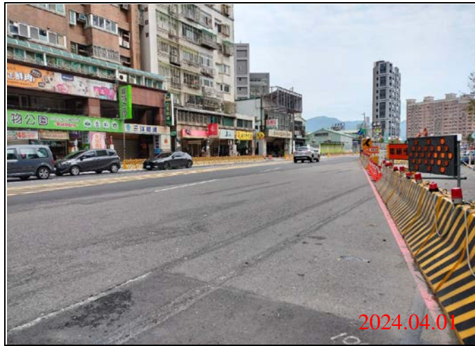
巡查日期地點：113.04.01/ Y22車站 照片說明：路面狀況
