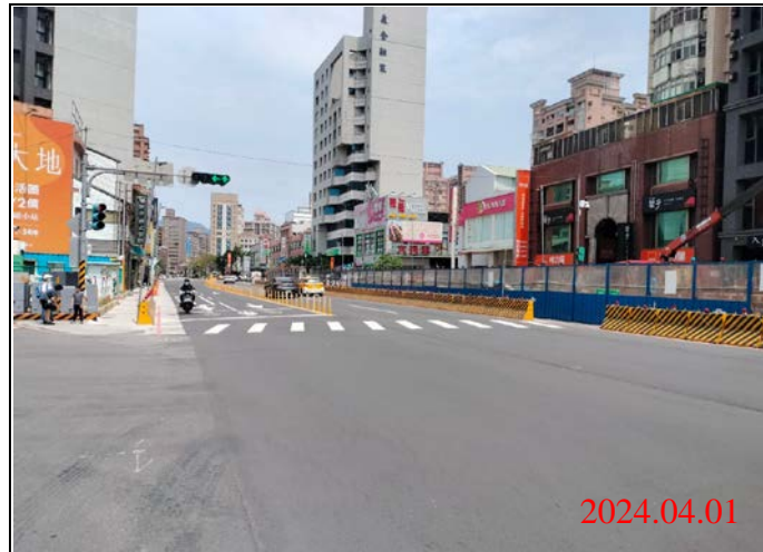
巡查日期地點：113.04.01/ Y21車站 照片說明：路面狀況
