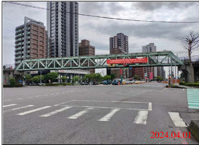
巡查日期地點：113.04.01/ Y23車站 照片說明：路面狀況
