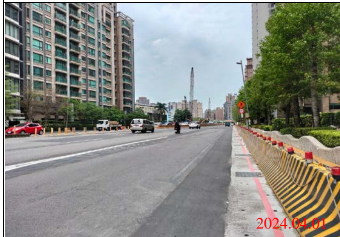
巡查日期地點：113.04.01/ Y23車站 照片說明：路面狀況
