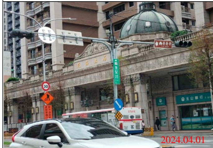
巡查日期地點：113.04.01/ Y22車站 照片說明：牌面設置狀況
