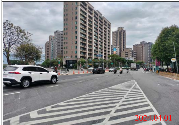
巡查日期地點：113.04.01/ Y22車站 照片說明：路面狀況
