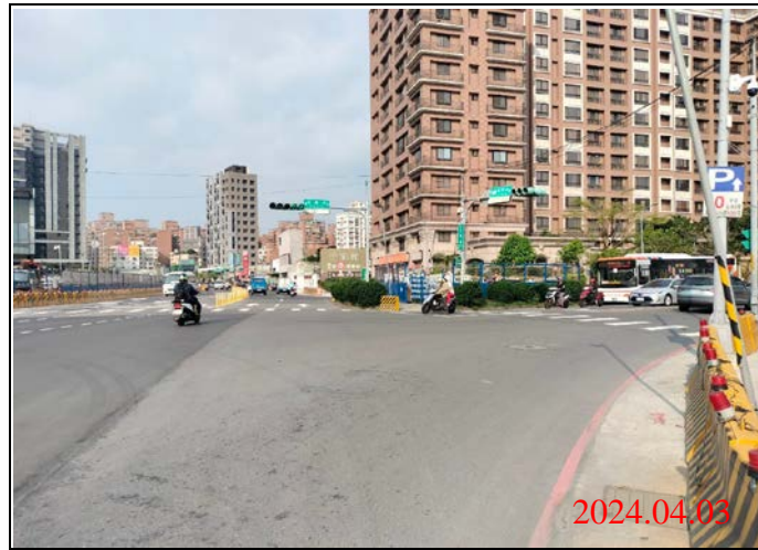
巡查日期地點：113.04.03/ Y22車站 照片說明：路面狀況
