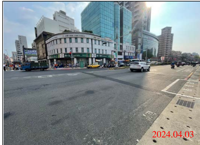
巡查日期地點：113.04.03/ Y21車站 照片說明：路面狀況
