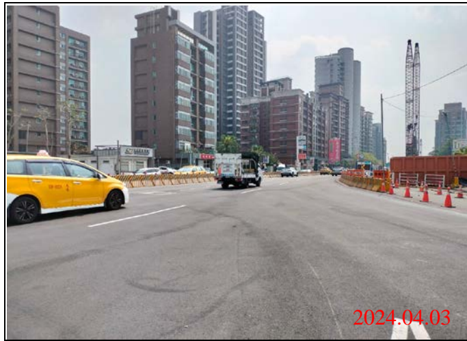
巡查日期地點：113.04.03/ Y23車站 照片說明：路面狀況
