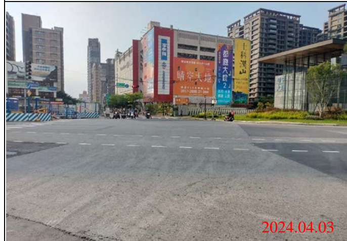
巡查日期地點：113.04.03/ Y22車站 照片說明：路面狀況
