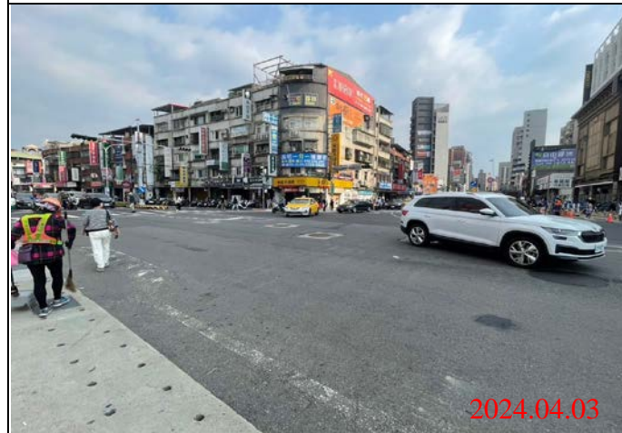
巡查日期地點：113.04.03/ Y21車站 照片說明：路面狀況
