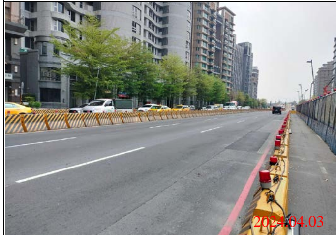
巡查日期地點：113.04.03/ Y23車站 照片說明：路面狀況
