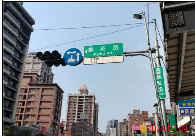
巡查日期地點：113.04.04/ Y22車站 照片說明：牌面設置狀況
