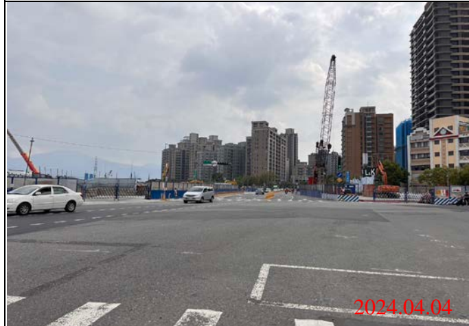
巡查日期地點：113.04.04/ Y22車站 照片說明：路面狀況
