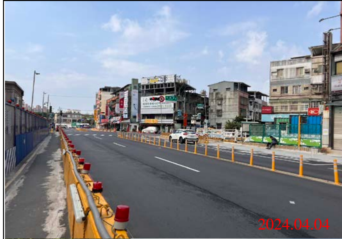
巡查日期地點：113.04.04/ Y21車站 照片說明：路面狀況
