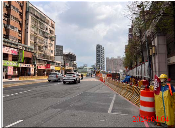
巡查日期地點：113.04.04/ Y22車站 照片說明：路面狀況
