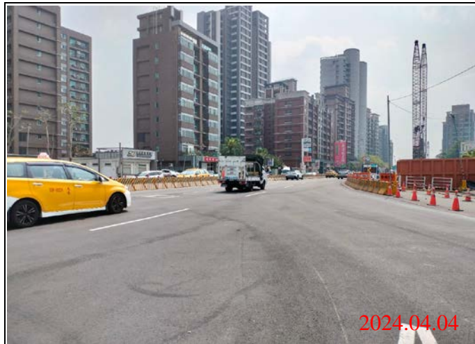
巡查日期地點：113.04.04/ Y23車站 照片說明：路面狀況
