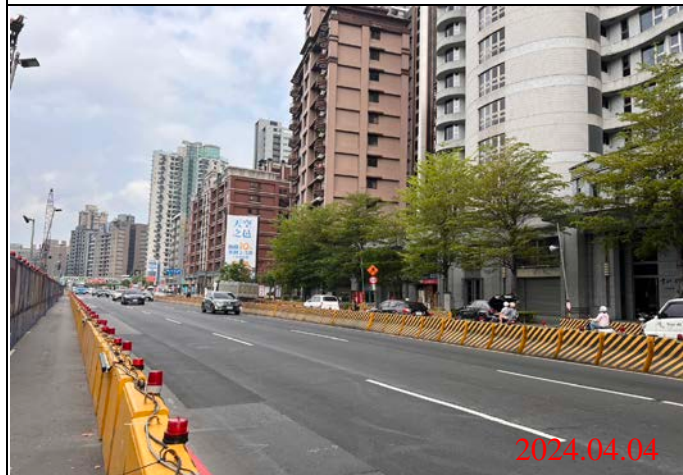
巡查日期地點：113.04.04/ Y23車站 照片說明：路面狀況
