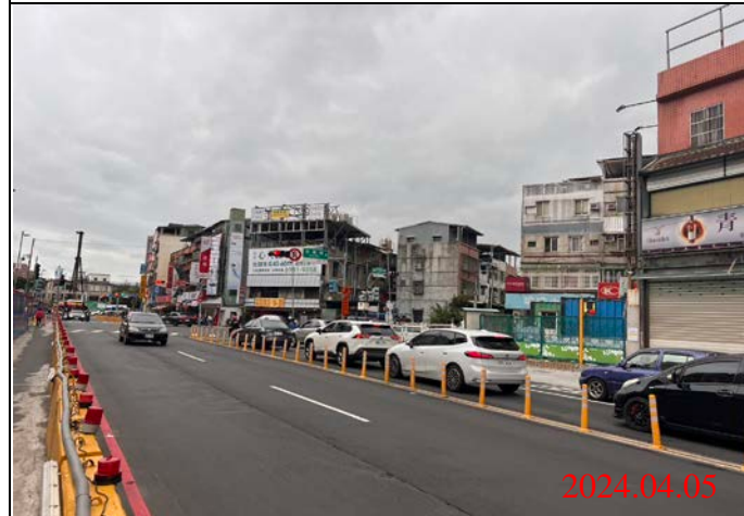
巡查日期地點：113.04.05/ Y21車站 照片說明：路面狀況
