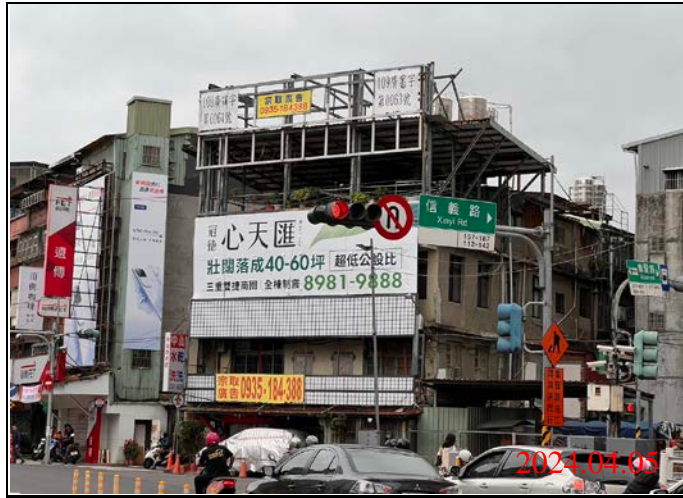
巡查日期地點：113.04.05/ Y21車站 照片說明：牌面設置狀況
