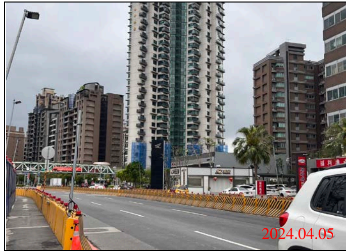
巡查日期地點：113.04.05/ Y23車站 照片說明：路面狀況
