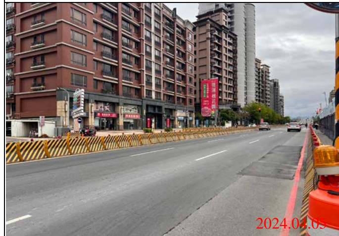
巡查日期地點：113.04.05/ Y23車站 照片說明：路面狀況
