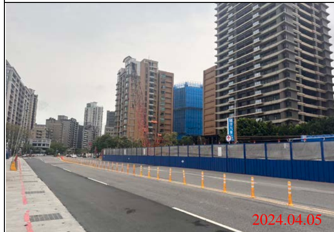
巡查日期地點：113.04.05/ Y22車站 照片說明：路面狀況
