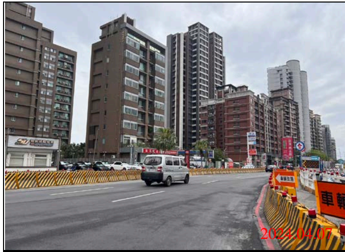
巡查日期地點：113.04.07/ Y23車站 照片說明：路面狀況
