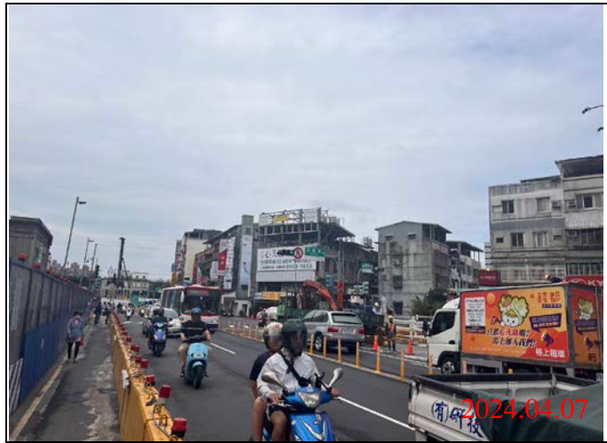
巡查日期地點：113.04.07/ Y21車站 照片說明：路面狀況
