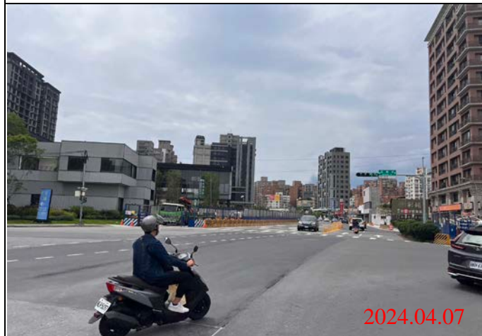
巡查日期地點：113.04.07/ Y22車站 照片說明：路面狀況
