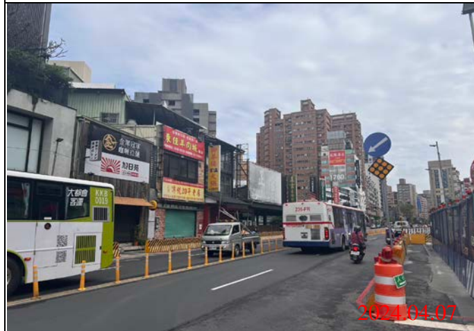
巡查日期地點：113.04.07/ Y21車站 照片說明：路面狀況
