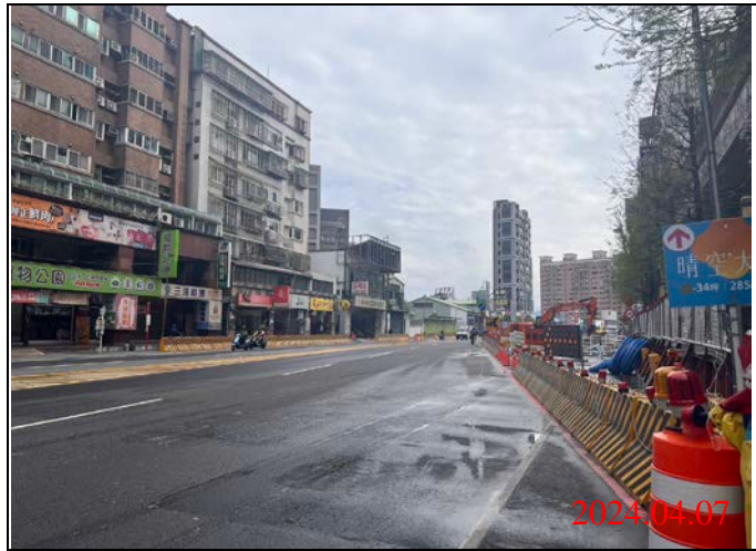
巡查日期地點：113.04.07/ Y22車站 照片說明：路面狀況
