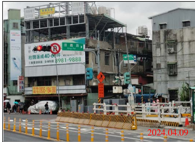
巡查日期地點：113.04.09/ Y21車站 照片說明：牌面設置狀況
