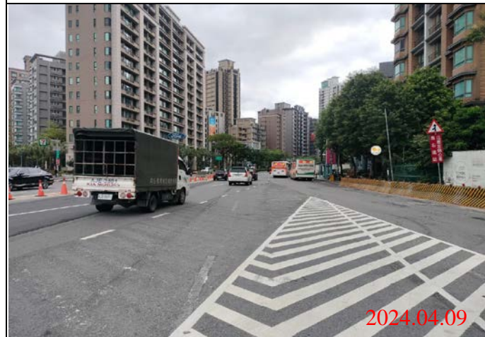
巡查日期地點：113.04.09/ Y22車站 照片說明：路面狀況
