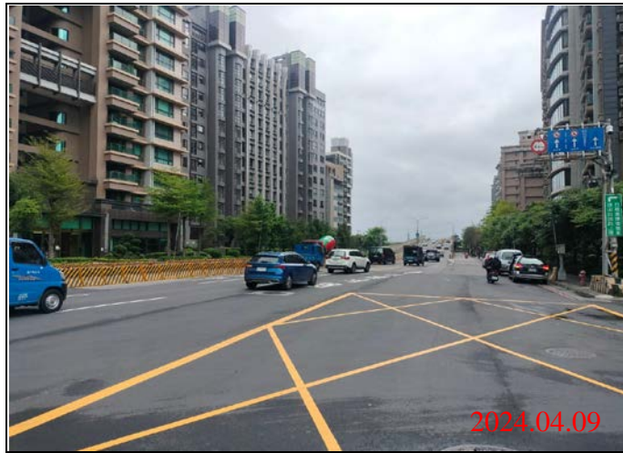
巡查日期地點：113.04.09/ Y23車站 照片說明：路面狀況
