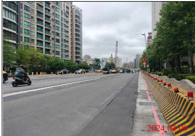
巡查日期地點：113.04.09/ Y23車站 照片說明：路面狀況
