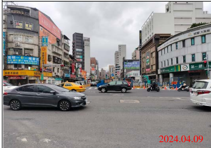
巡查日期地點：113.04.09/ Y21車站 照片說明：路面狀況
