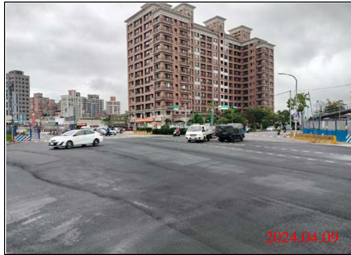
巡查日期地點：113.04.09/ Y22車站 照片說明：路面狀況
