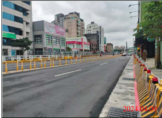
巡查日期地點：113.04.09/ Y21車站 照片說明：路面狀況
