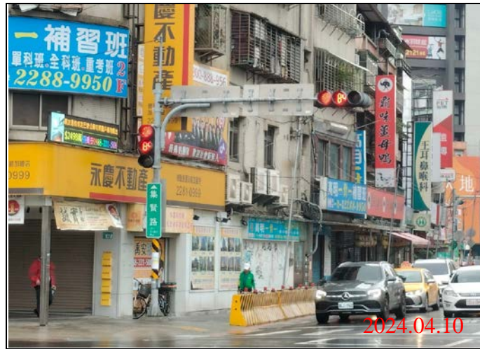
巡查日期地點：113.04.10/ Y21車站 照片說明：牌面設置狀況
