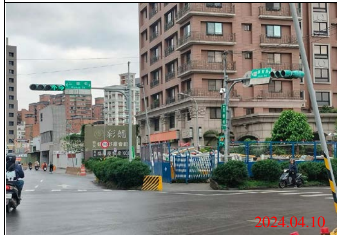
巡查日期地點：113.04.10/ Y22車站 照片說明：牌面設置狀況
