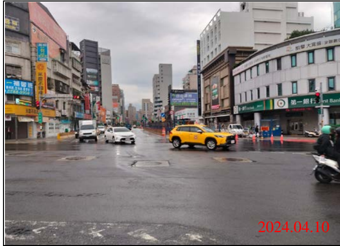
巡查日期地點：113.04.10/ Y21車站 照片說明：路面狀況
