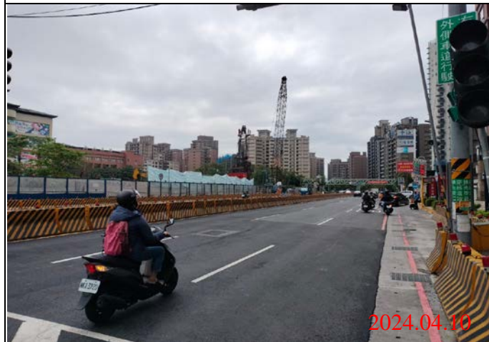
巡查日期地點：113.04.10/ Y23車站 照片說明：路面狀況
