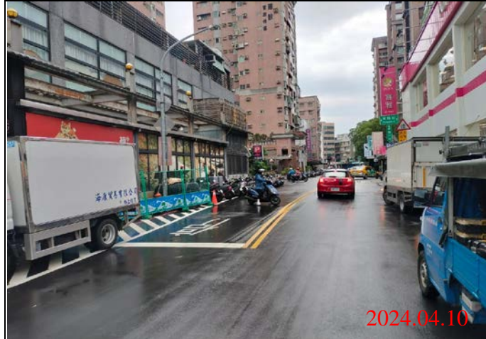
巡查日期地點：113.04.10/ Y21車站 照片說明：路面狀況
