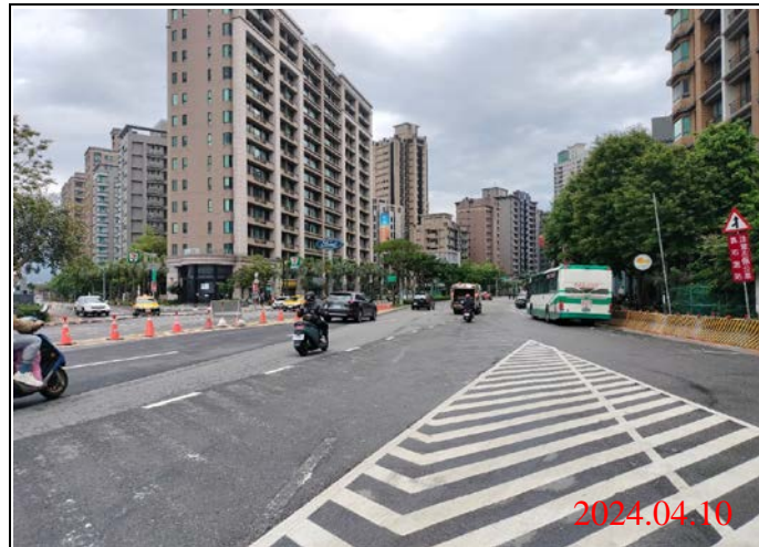
巡查日期地點：113.04.10/ Y22車站 照片說明：路面狀況
