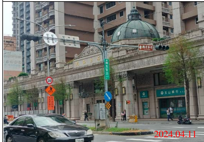
巡查日期地點：113.04.11/ Y22車站 照片說明：牌面設置狀況
