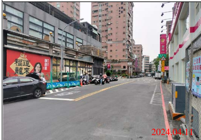
巡查日期地點：113.04.11/ Y21車站 照片說明：路面狀況
