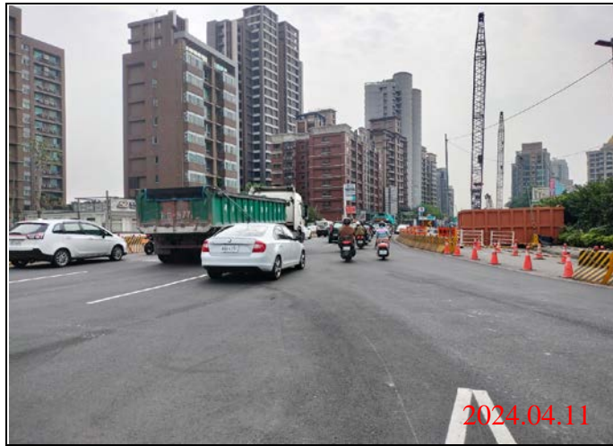
巡查日期地點：113.04.11/ Y23車站 照片說明：路面狀況
