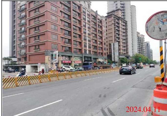
巡查日期地點：113.04.11/ Y23車站 照片說明：路面狀況
