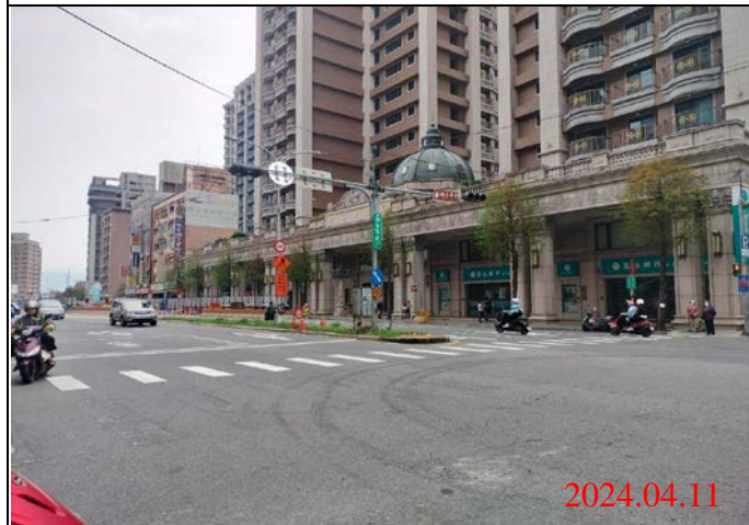
巡查日期地點：113.04.11/ Y22車站 照片說明：路面狀況
