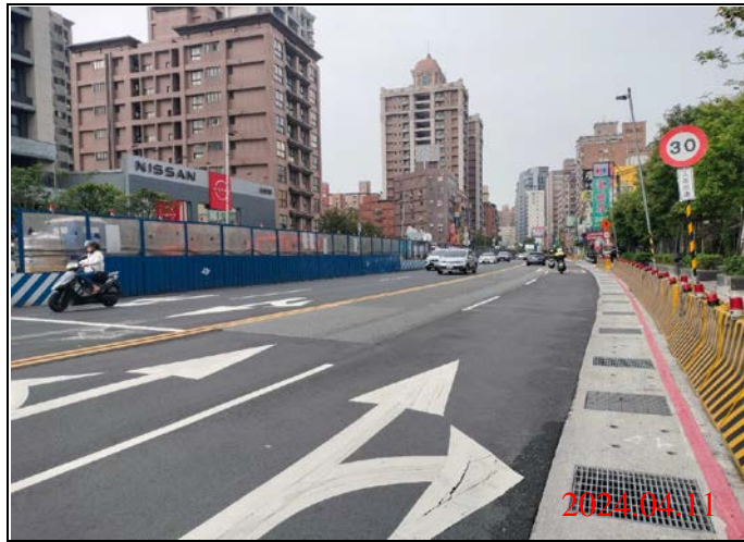
巡查日期地點：113.04.11/ Y22車站 照片說明：路面狀況
