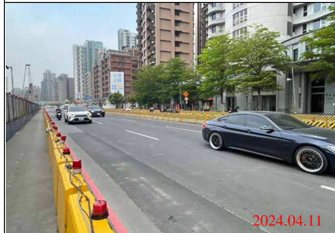
巡查日期地點：113.04.12/ Y23車站 照片說明：路面狀況
