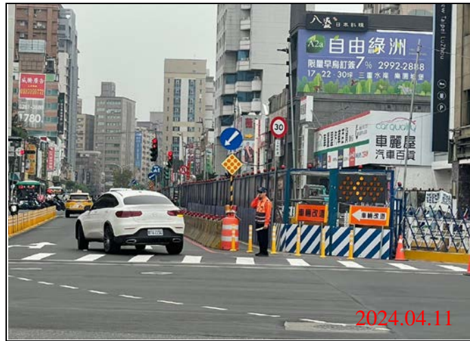
巡查日期地點：113.04.12/ Y21車站 照片說明：牌面設置狀況
