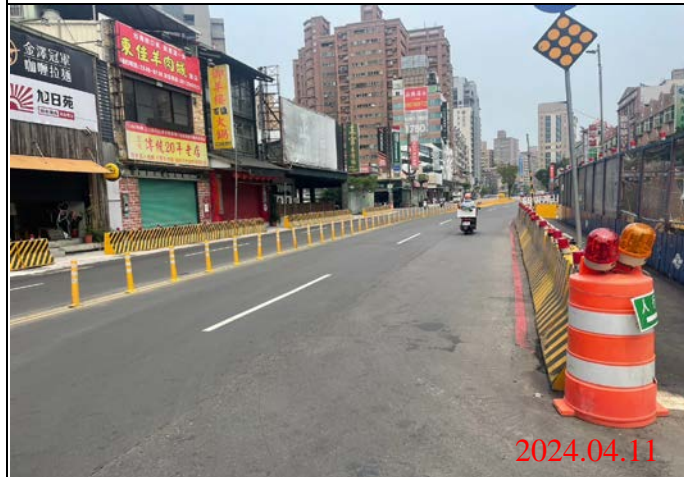
巡查日期地點：113.04.12/ Y21車站 照片說明：路面狀況
