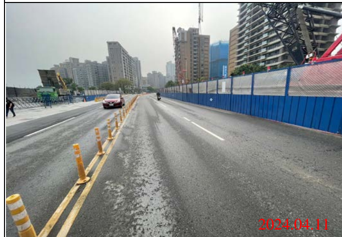
巡查日期地點：113.04.12/ Y22車站 照片說明：路面狀況
