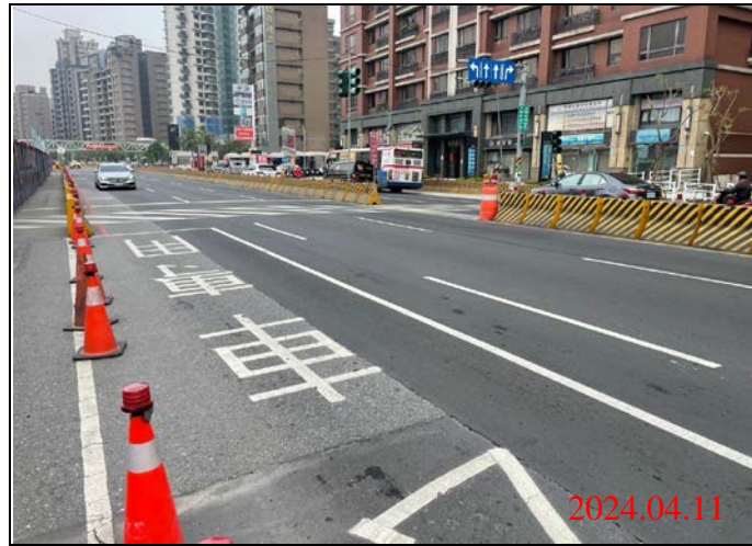
巡查日期地點：113.04.12/ Y23車站 照片說明：路面狀況
