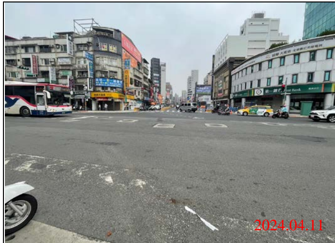
巡查日期地點：113.04.12/ Y21車站 照片說明：路面狀況
