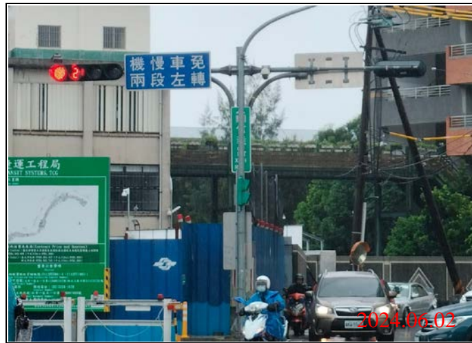
巡查日期地點：113.06.02/ Y21車站 照片說明：牌面設置狀況
