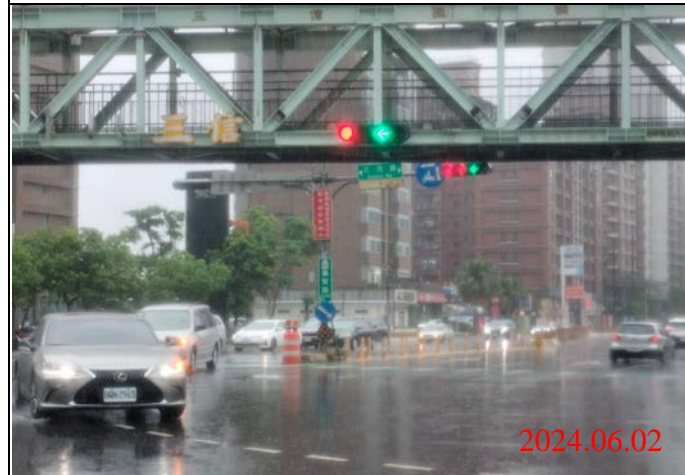
巡查日期地點：113.06.02/ Y23車站 照片說明：牌面設置狀況
