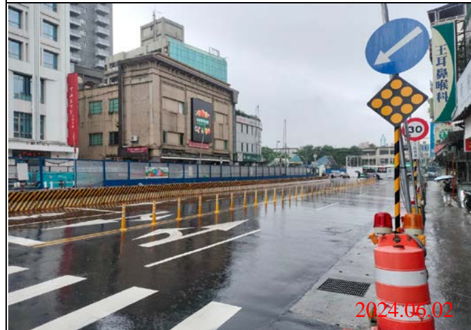
巡查日期地點：113.06.02/ Y21車站 照片說明：路面狀況
