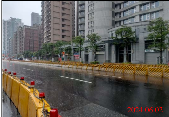
巡查日期地點：113.06.02/ Y23車站 照片說明：路面狀況
