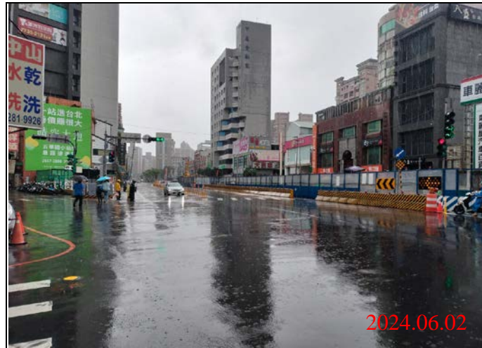
巡查日期地點：113.06.02/ Y21車站 照片說明：路面狀況
