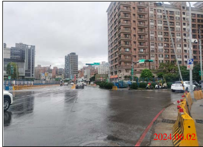
巡查日期地點：113.06.02/ Y22車站 照片說明：路面狀況
