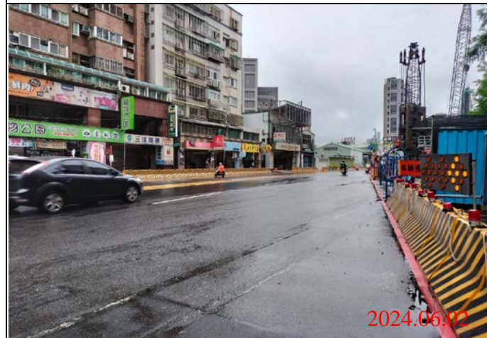
巡查日期地點：113.06.02/ Y22車站 照片說明：路面狀況
