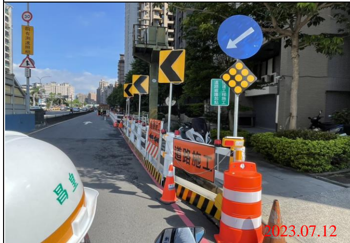
巡查日期地點：112.07.12/ Y23車站 照片說明：牌面設置狀況
