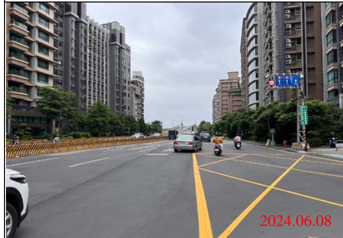
巡查日期地點：113.06.08/ Y23車站 照片說明：牌面設置狀況
