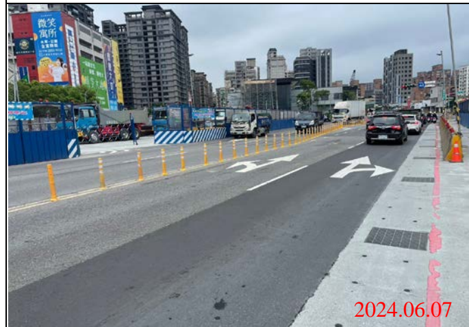
巡查日期地點：113.06.08/ Y22車站 照片說明：路面狀況
