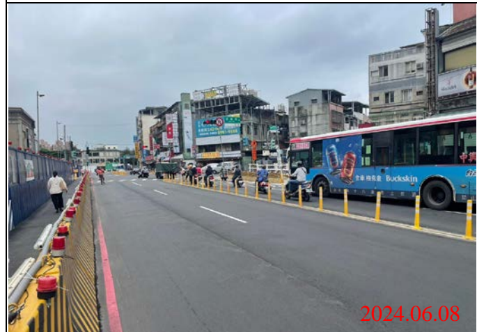
巡查日期地點：113.06.08/ Y21車站 照片說明：路面狀況
