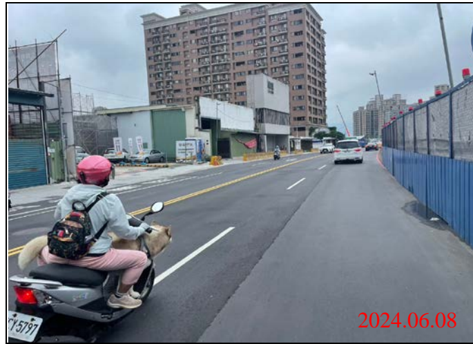
巡查日期地點：113.06.08/ Y22車站 照片說明：路面狀況
