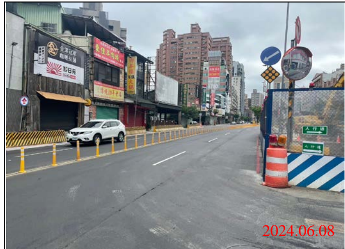
巡查日期地點：113.06.08/ Y21車站 照片說明：路面狀況
