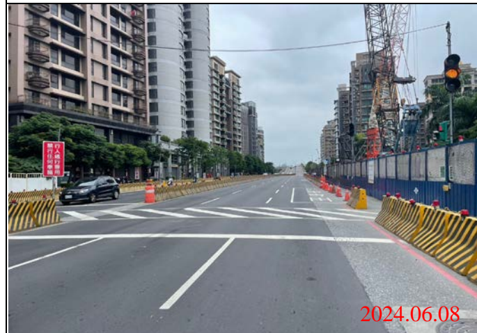
巡查日期地點：113.06.08/ Y23車站 照片說明：路面狀況
