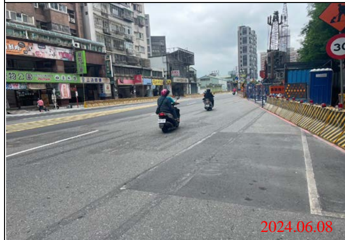
巡查日期地點：113.06.08/ Y22車站 照片說明：牌面設置狀況
