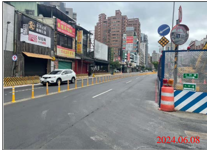
巡查日期地點：113.06.08/ Y21車站 照片說明：牌面設置狀況
