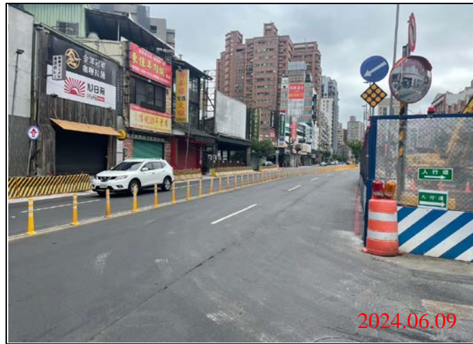
巡查日期地點：113.06.09/ Y21車站 照片說明：牌面設置狀況
