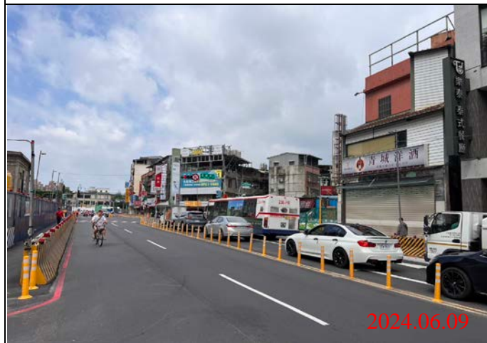
巡查日期地點：113.06.09/ Y21車站 照片說明：路面狀況
