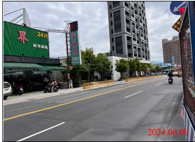
巡查日期地點：113.06.09/ Y22車站 照片說明：路面狀況
