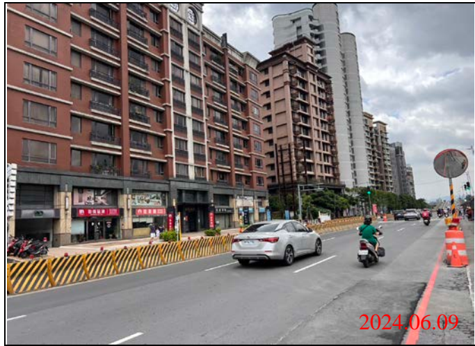
巡查日期地點：113.06.09/ Y23車站 照片說明：路面狀況
