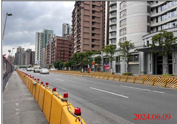
巡查日期地點：113.06.09/ Y23車站 照片說明：路面狀況
