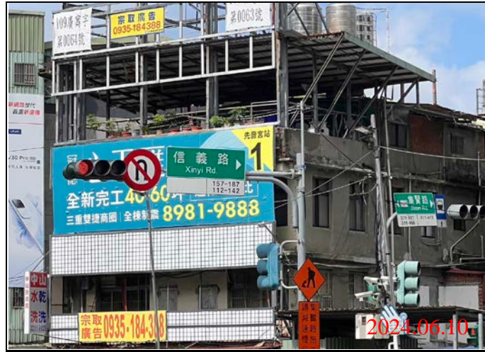
巡查日期地點：113.06.10/ Y21車站 照片說明：牌面設置狀況
