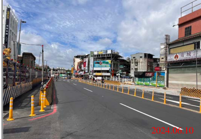
巡查日期地點：113.06.10/ Y21車站 照片說明：路面狀況
