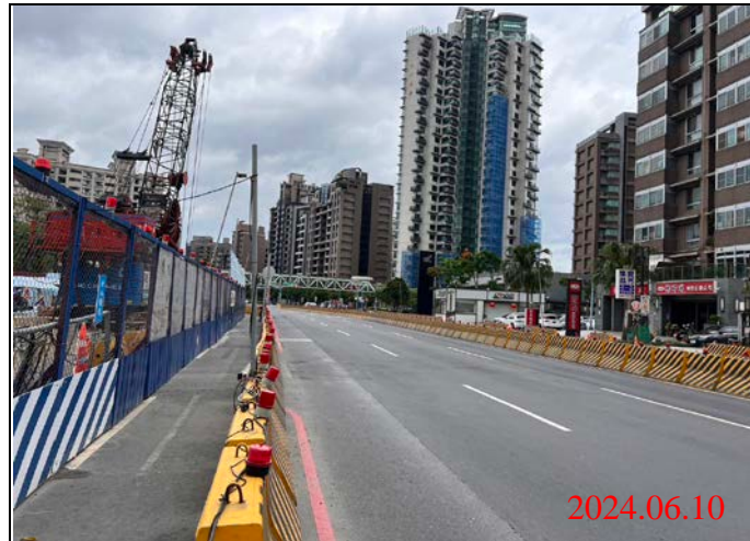
巡查日期地點：113.06.10/ Y23車站 照片說明：路面狀況
