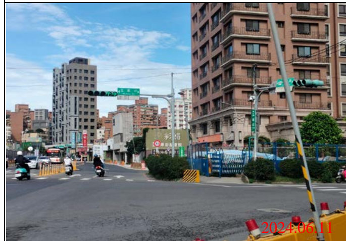
巡查日期地點：113.06.11/ Y22車站 照片說明：牌面設置狀況
