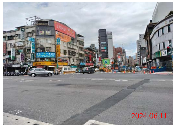
巡查日期地點：113.06.11/ Y21車站 照片說明：路面狀況
