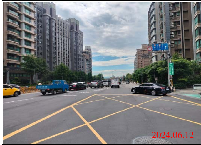
巡查日期地點：113.06.12/-23車站 照片說明：路面狀況
