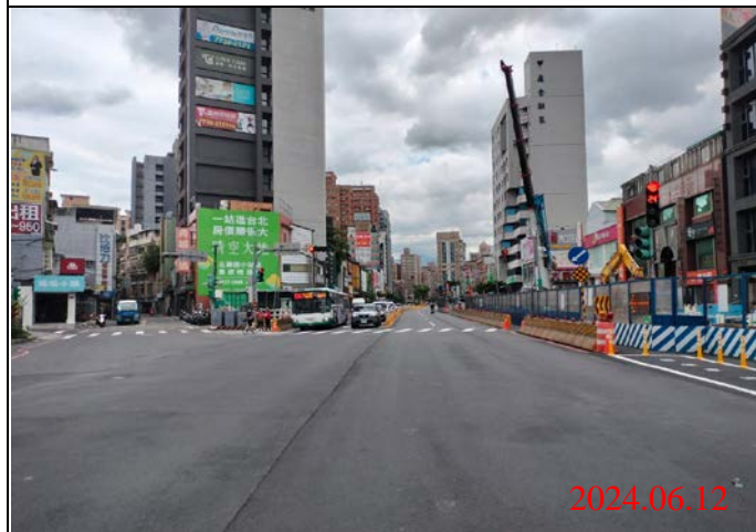
巡查日期地點：113.06.12/ Y21車站 照片說明：路面狀況
