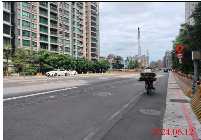
巡查日期地點：113.06.12/ Y23車站 照片說明：路面狀況
