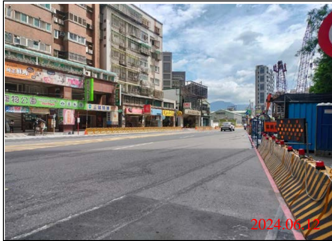
巡查日期地點：113.06.12/ Y22車站 照片說明：路面狀況
