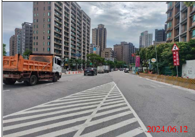
巡查日期地點：113.06.12/ Y22車站 照片說明：路面狀況
