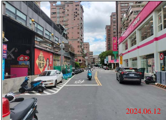
巡查日期地點：113.06.12/ Y21車站 照片說明：路面狀況
