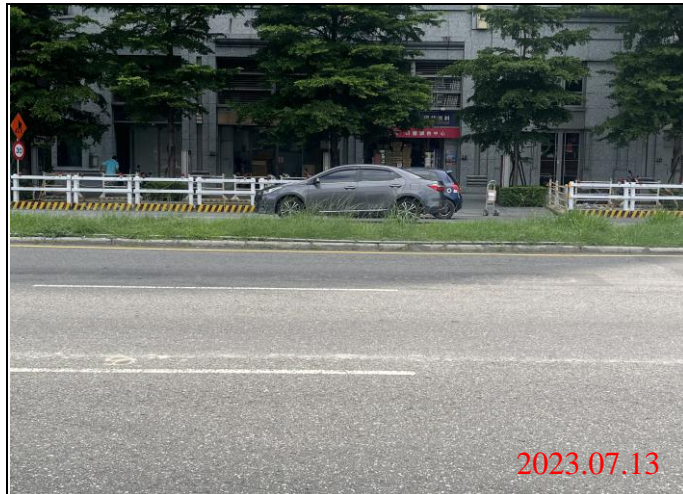
巡查日期地點：112.07.13/ Y23車站 照片說明：路面龜裂狀況
