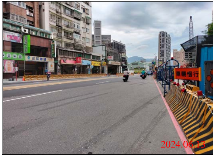
巡查日期地點：113.06.13/ Y22車站 照片說明：路面狀況
