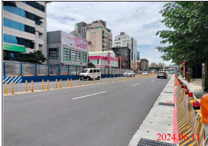
巡查日期地點：113.06.13/ Y21車站 照片說明：路面狀況
