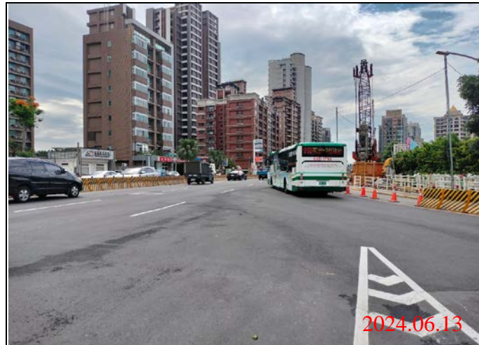
巡查日期地點：113.06.13/-23車站 照片說明：路面狀況
