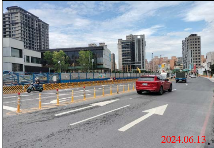
巡查日期地點：113.06.13/ Y22車站 照片說明：路面狀況
