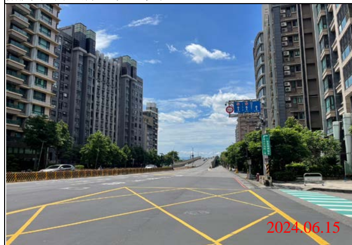
巡查日期地點：113.06.15/ Y23車站 照片說明：牌面設置狀況
