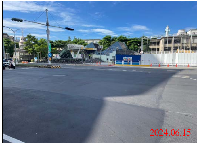
巡查日期地點：113.06.15/ Y21車站 照片說明：路面狀況
