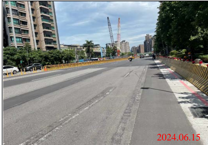
巡查日期地點：113.06.15/ Y23車站 照片說明：路面狀況
