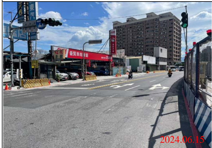
巡查日期地點：113.06.15/ Y22車站 照片說明：路面狀況
