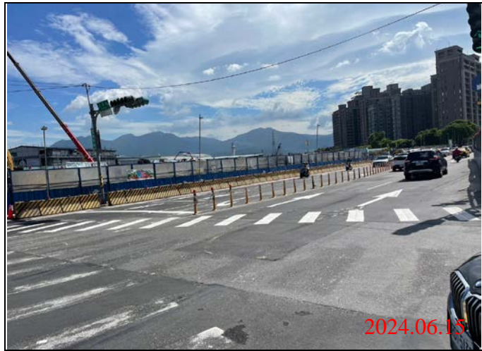
巡查日期地點：113.06.15/ Y22車站 照片說明：路面狀況
