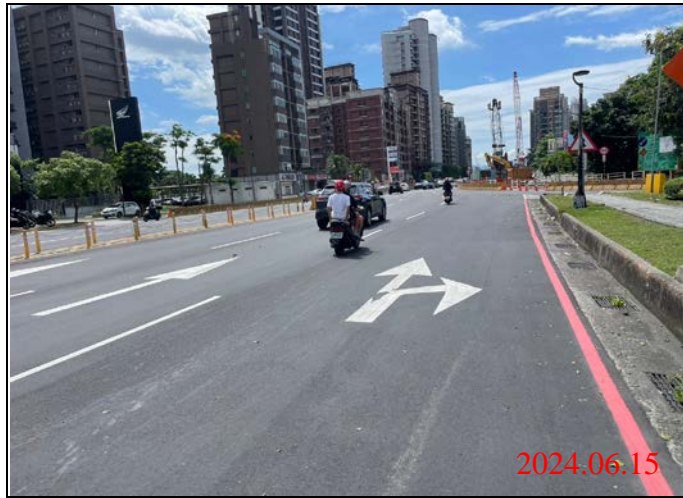
巡查日期地點：113.06.15/-23車站 照片說明：路面狀況
