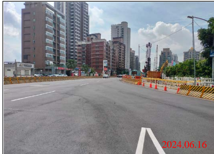
巡查日期地點：113.06.16/-23車站 照片說明：路面狀況
