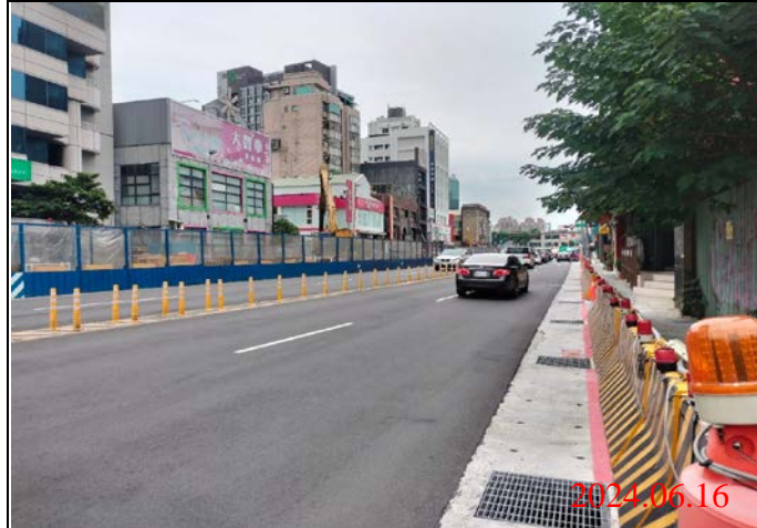
巡查日期地點：113.06.16/ Y21車站 照片說明：路面狀況
