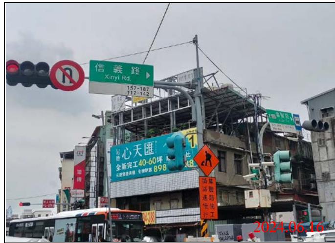
巡查日期地點：113.06.16/ Y21車站 照片說明：牌面設置狀況
