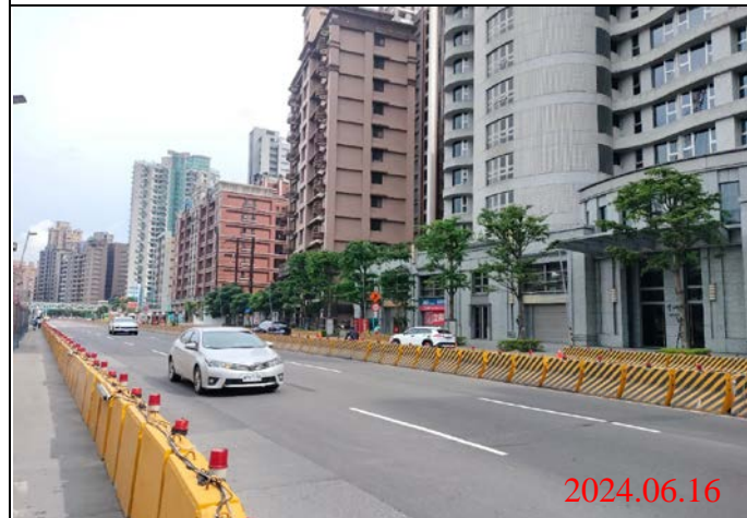
巡查日期地點：113.06.16/ Y23車站 照片說明：路面狀況
