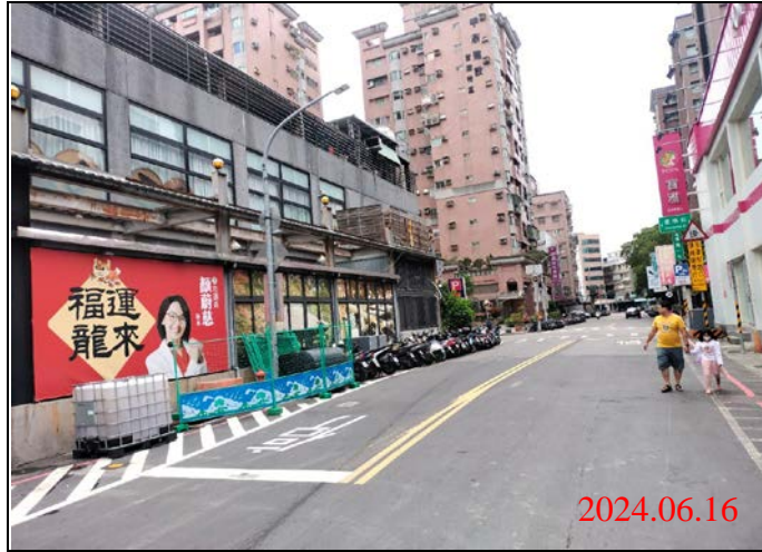
巡查日期地點：113.06.16/ Y21車站 照片說明：路面狀況
