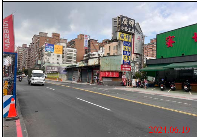
巡查日期地點：113.06.19/ Y22車站 照片說明：路面狀況
