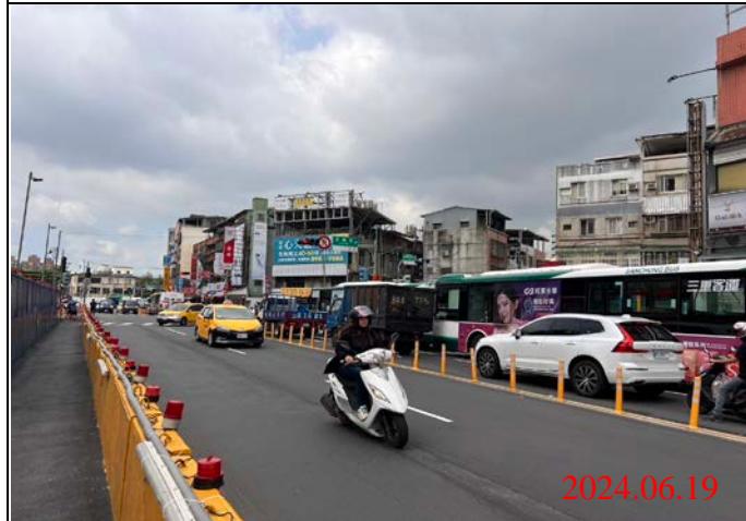
巡查日期地點：113.06.19/ Y21車站 照片說明：路面狀況
