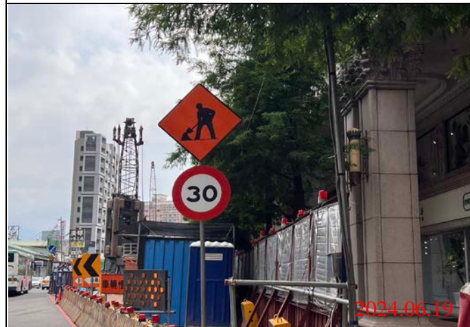
巡查日期地點：113.06.19/ Y22車站 照片說明：牌面設置狀況
