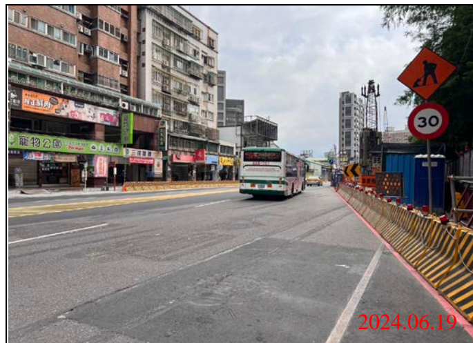
巡查日期地點：113.06.19/ Y22車站 照片說明：路面狀況
