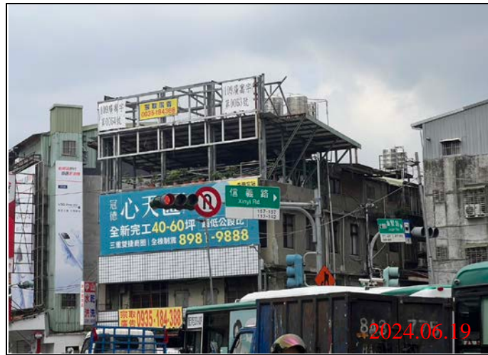
巡查日期地點：113.06.19/ Y21車站 照片說明：牌面設置狀況
