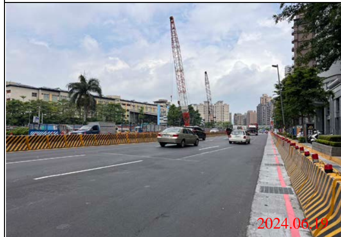
巡查日期地點：113.06.19/ Y23車站 照片說明：路面狀況
