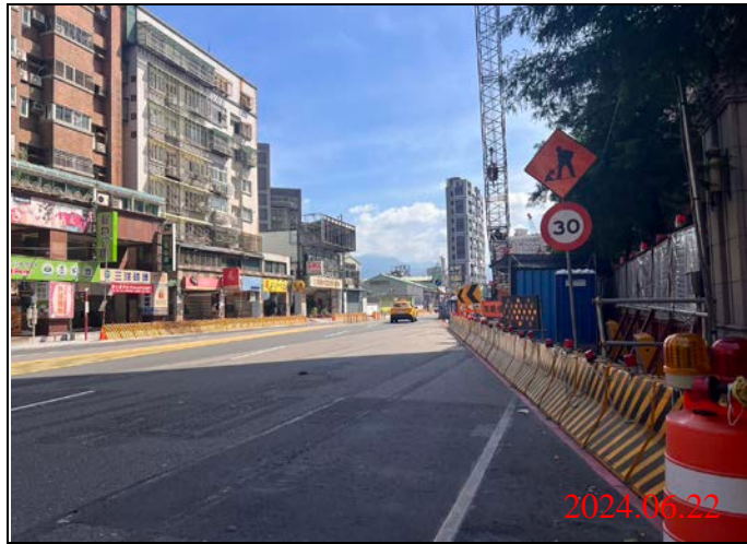
巡查日期地點：113.06.22/ Y22車站 照片說明：路面狀況
