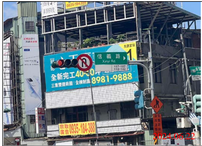
巡查日期地點：113.06.22/ Y21車站 照片說明：牌面設置狀況
