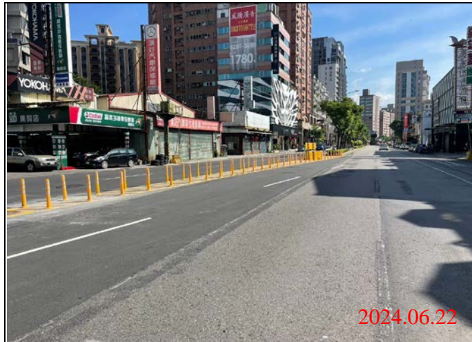
巡查日期地點：113.06.22/ Y21車站 照片說明：路面狀況
