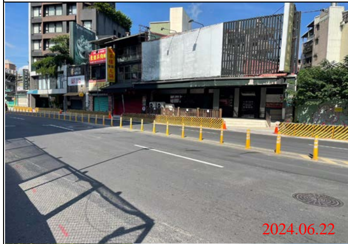
巡查日期地點：113.06.22/ Y21車站 照片說明：路面狀況
