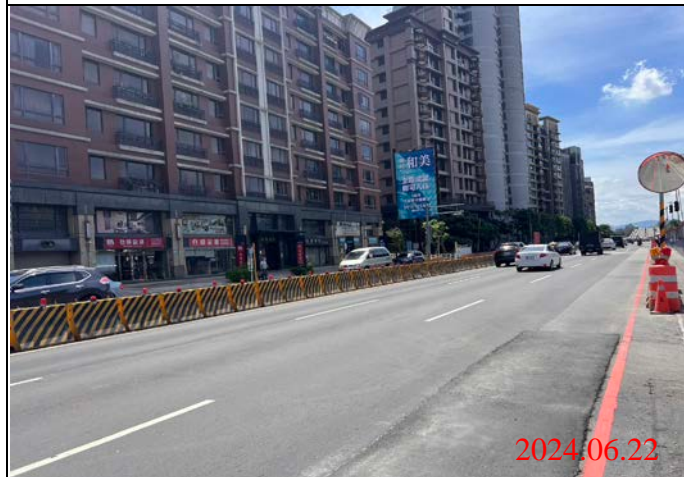
巡查日期地點：113.06.22/ Y23車站 照片說明：路面狀況
