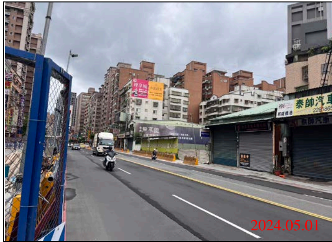
巡查日期地點：113.05.01/ Y22車站 照片說明：路面狀況
