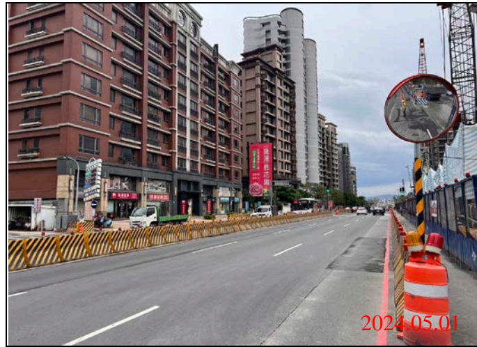
巡查日期地點：113.05.01/ Y23車站 照片說明：路面狀況
