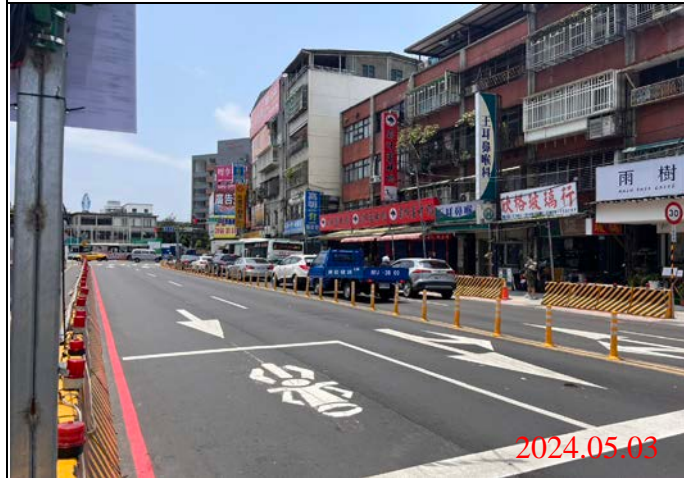
巡查日期地點：113.05.03/ Y21車站 照片說明：路面狀況
