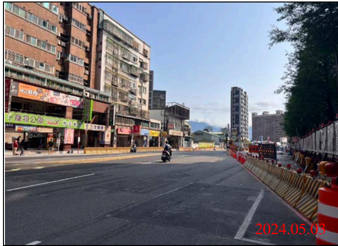
巡查日期地點：113.05.03/ Y22車站 照片說明：路面狀況
