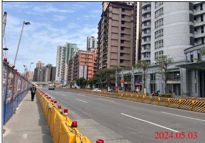
巡查日期地點：113.05.03/ Y23車站 照片說明：路面狀況
