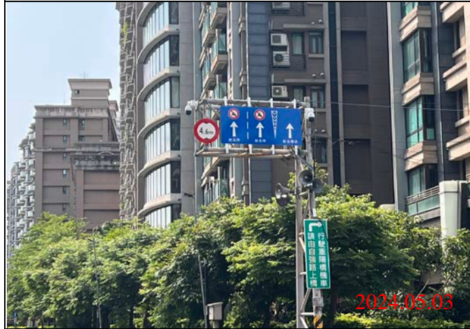
巡查日期地點：113.05.03/ Y23車站 照片說明：牌面設置狀況
