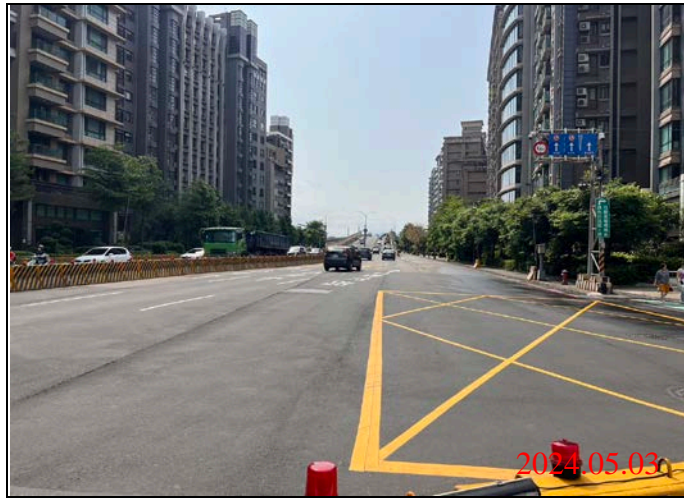
巡查日期地點：113.05.03/ Y23車站 照片說明：路面狀況
