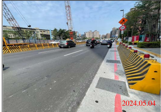
巡查日期地點：113.05.04/ Y23車站 照片說明：牌面設置狀況
