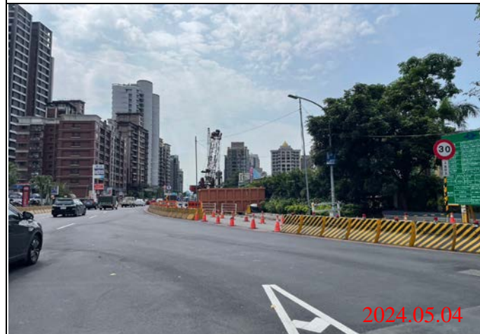
巡查日期地點：113.05.04/ Y23車站 照片說明：路面狀況
