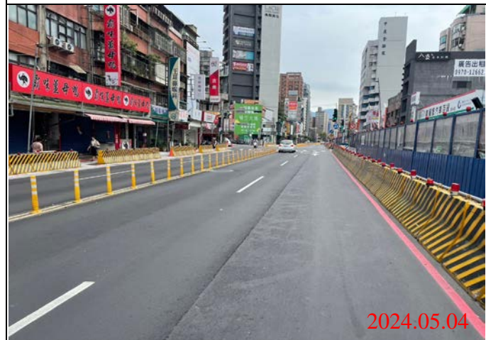
巡查日期地點：113.05.04/ Y21車站 照片說明：路面狀況
