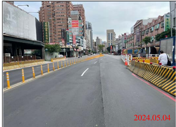
巡查日期地點：113.05.04/ Y21車站 照片說明：路面狀況
