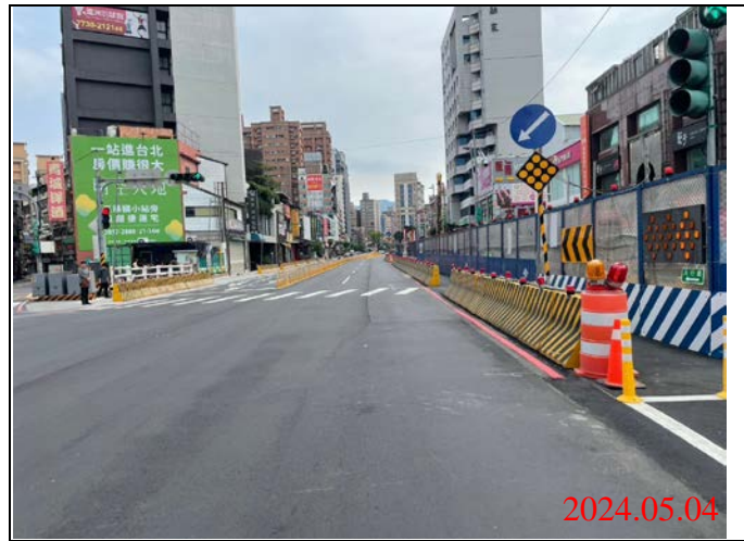
巡查日期地點：113.05.04/ Y21車站 照片說明：牌面設置狀況
