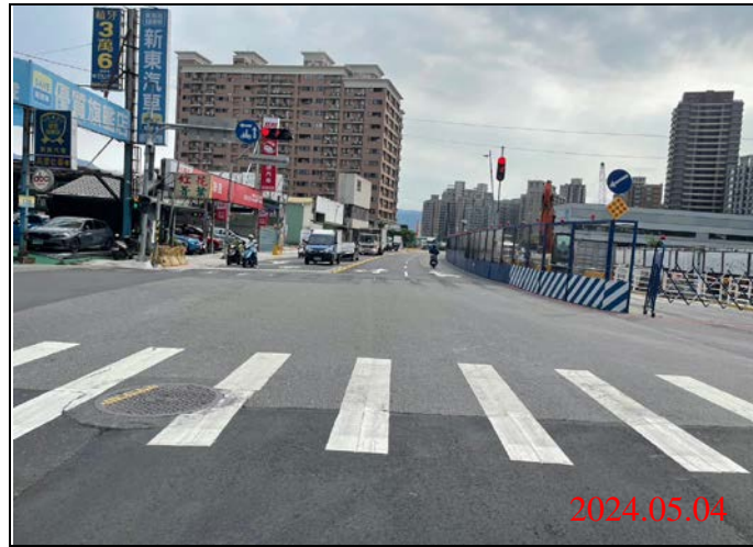
巡查日期地點：113.05.04/ Y22車站 照片說明：路面狀況
