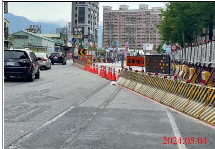
巡查日期地點：113.05.04/ Y22車站 照片說明：牌面設置狀況
