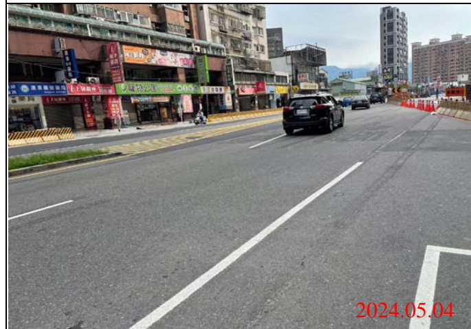
巡查日期地點：113.05.04/ Y22車站 照片說明：路面狀況
