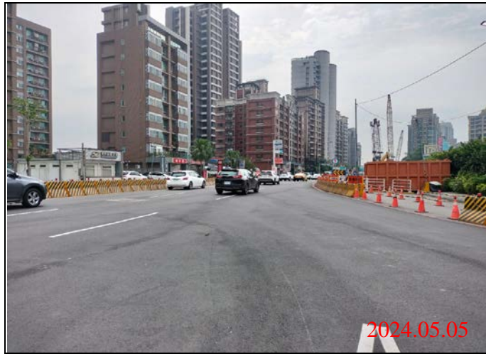
巡查日期地點：113.05.05/ Y23車站 照片說明：路面狀況
