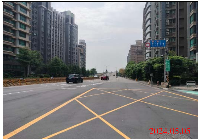
巡查日期地點：113.05.05/ Y23車站 照片說明：路面狀況
