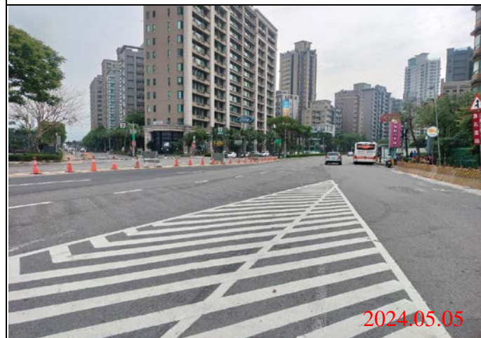
巡查日期地點：113.05.05/ Y22車站 照片說明：路面狀況
