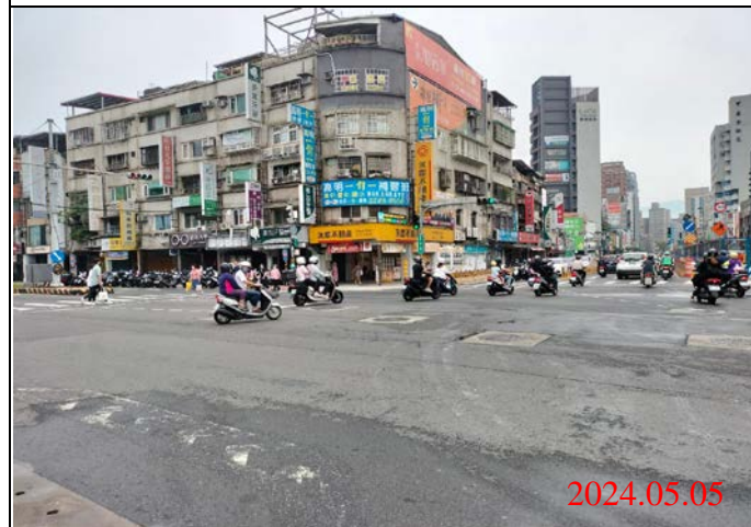
巡查日期地點：113.05.05/ Y21車站 照片說明：路面狀況
