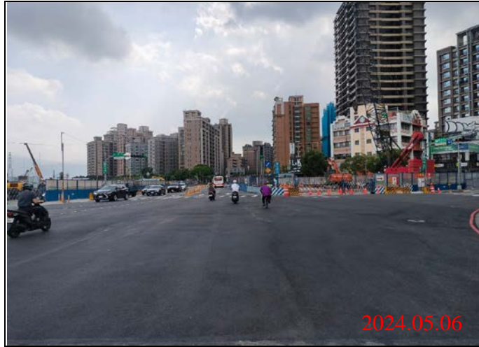
巡查日期地點：113.05.06/ Y22車站 照片說明：路面狀況
