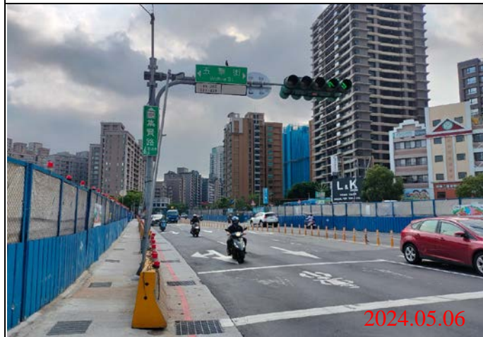
巡查日期地點：113.05.06/ Y22車站 照片說明：牌面設置狀況
