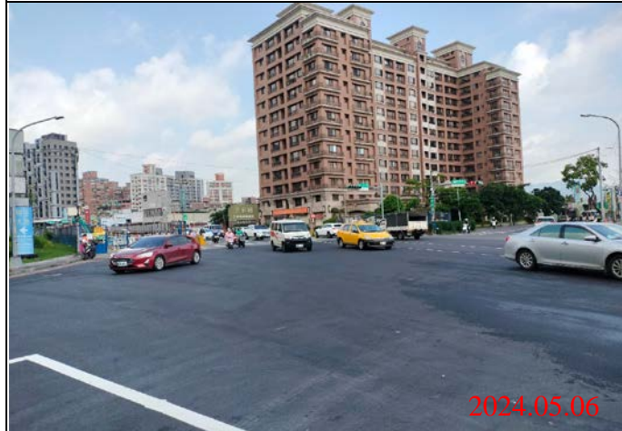
巡查日期地點：113.05.06/ Y22車站 照片說明：路面狀況
