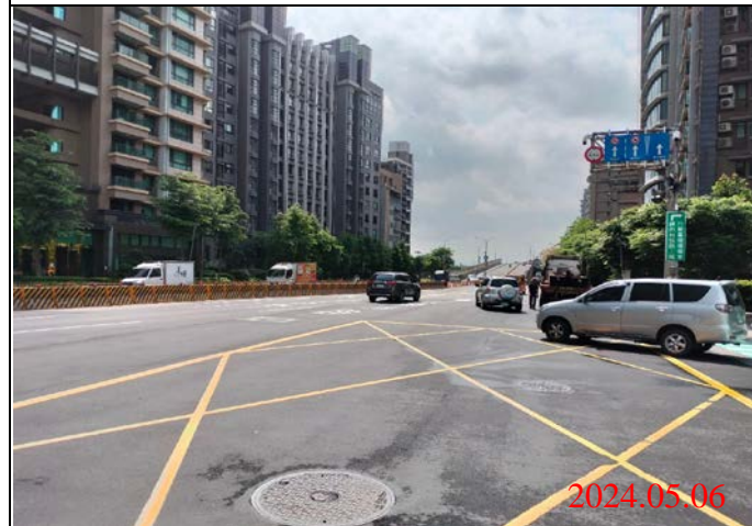
巡查日期地點：113.05.06/ Y23車站 照片說明：路面狀況
