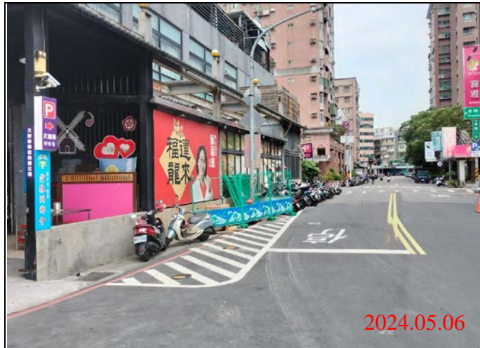
巡查日期地點：113.05.06/ Y21車站 照片說明：路面狀況
