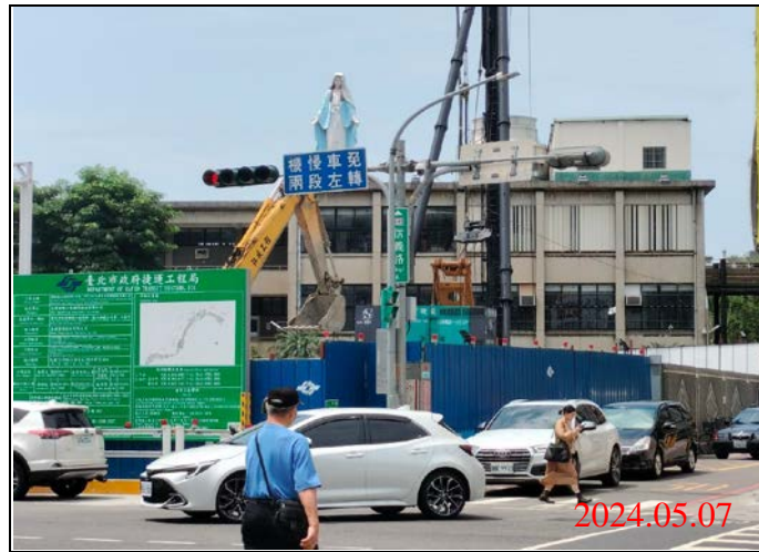
巡查日期地點：113.05.07/ Y21車站 照片說明：牌面設置狀況
