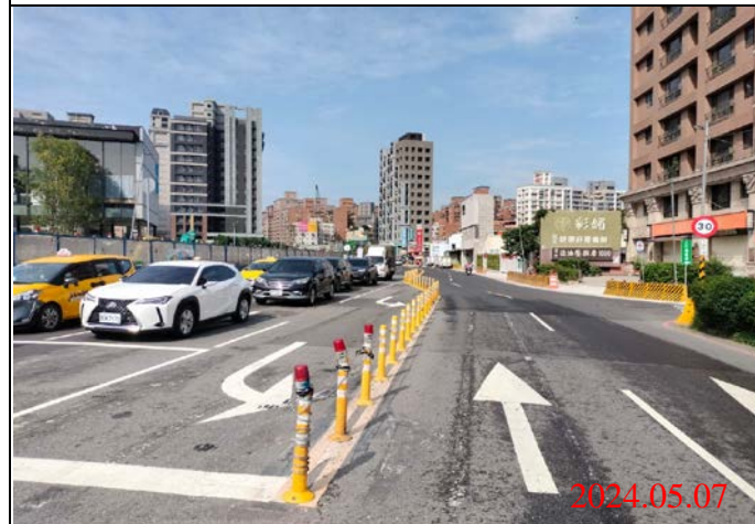
巡查日期地點：113.05.07/ Y22車站 照片說明：路面狀況
