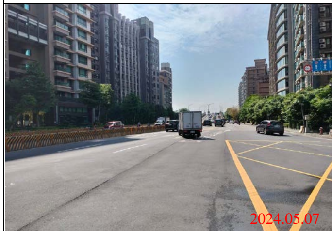
巡查日期地點：113.05.07/ Y23車站 照片說明：路面狀況
