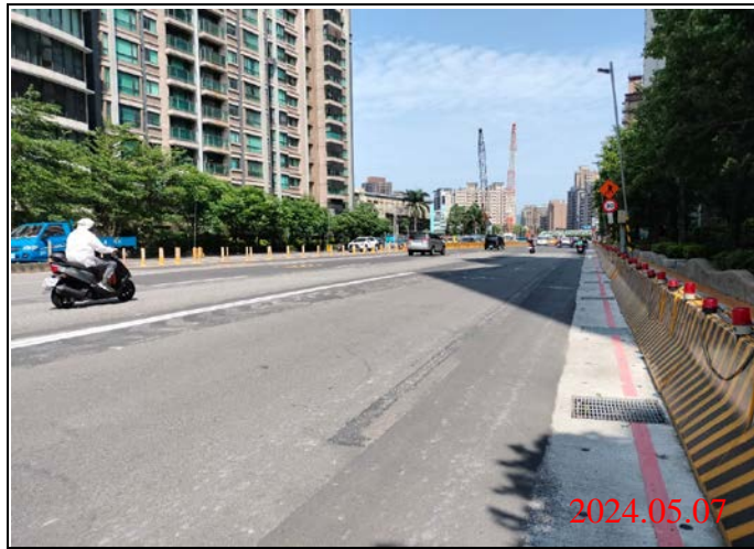
巡查日期地點：113.05.07/ Y23車站 照片說明：路面狀況
