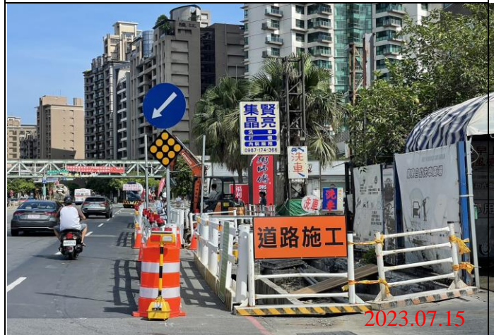
巡查日期地點：112.07.15/ Y23車站 照片說明：牌面設置狀況
