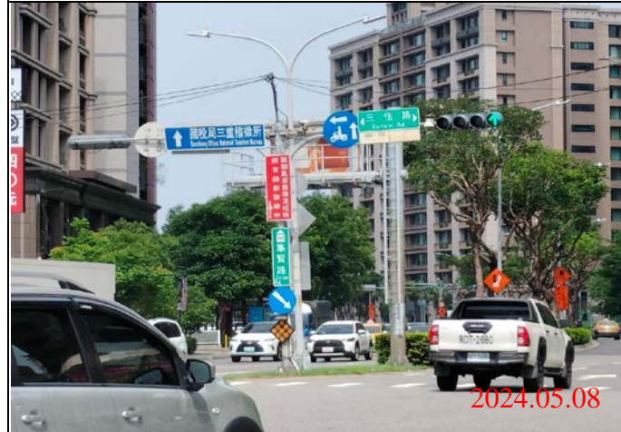
巡查日期地點：113.05.08/ Y23車站 照片說明：牌面設置狀況
