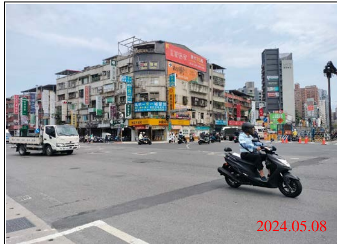
巡查日期地點：113.05.08/ Y21車站 照片說明：路面狀況
