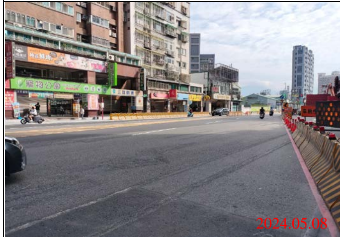
巡查日期地點：113.05.08/ Y22車站 照片說明：路面狀況
