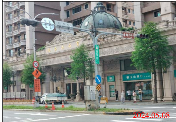
巡查日期地點：113.05.08/ Y22車站 照片說明：牌面設置狀況
