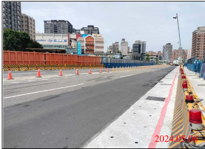
巡查日期地點：113.05.08/ Y22車站 照片說明：路面狀況
