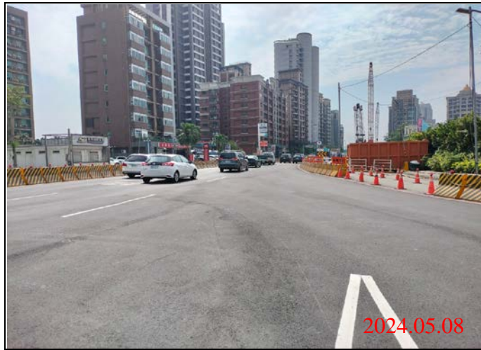
巡查日期地點：113.05.08/ Y23車站 照片說明：路面狀況
