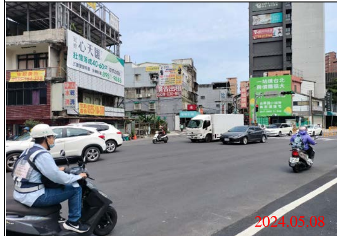
巡查日期地點：113.05.08/ Y21車站 照片說明：路面狀況
