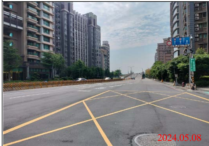
巡查日期地點：113.05.08/ Y23車站 照片說明：路面狀況
